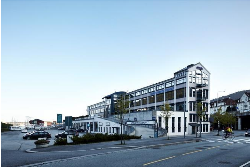
Ombygging av Utrustningsbygget fra et kontorbygg til et avansert Helsehus for Bergen Kommune og Helse Bergen startet i 2014. Planlagt innflytting er årsskiftet 2015/2016.
