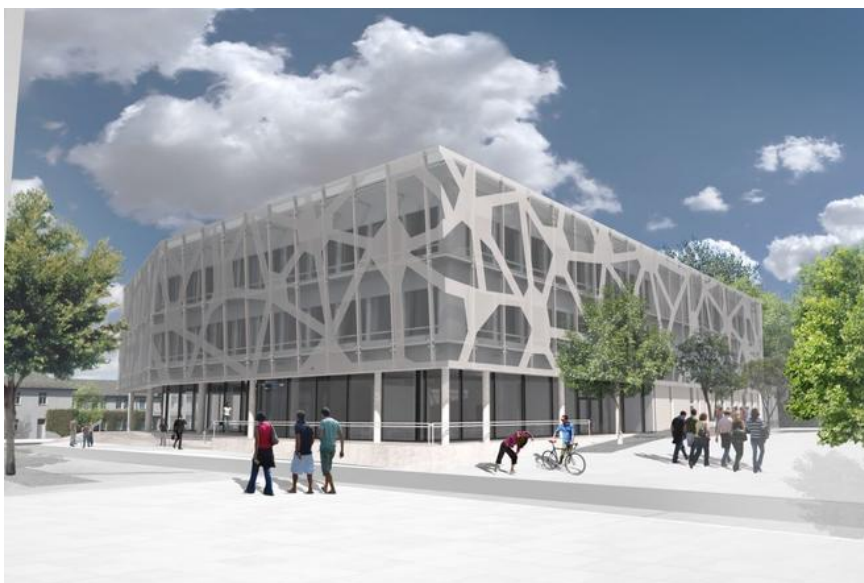
I 2014 startet byggingen av Det Norske Veritas GL sitt bygg på Marineholmen. Bygget skal stå klart i september 2016.
