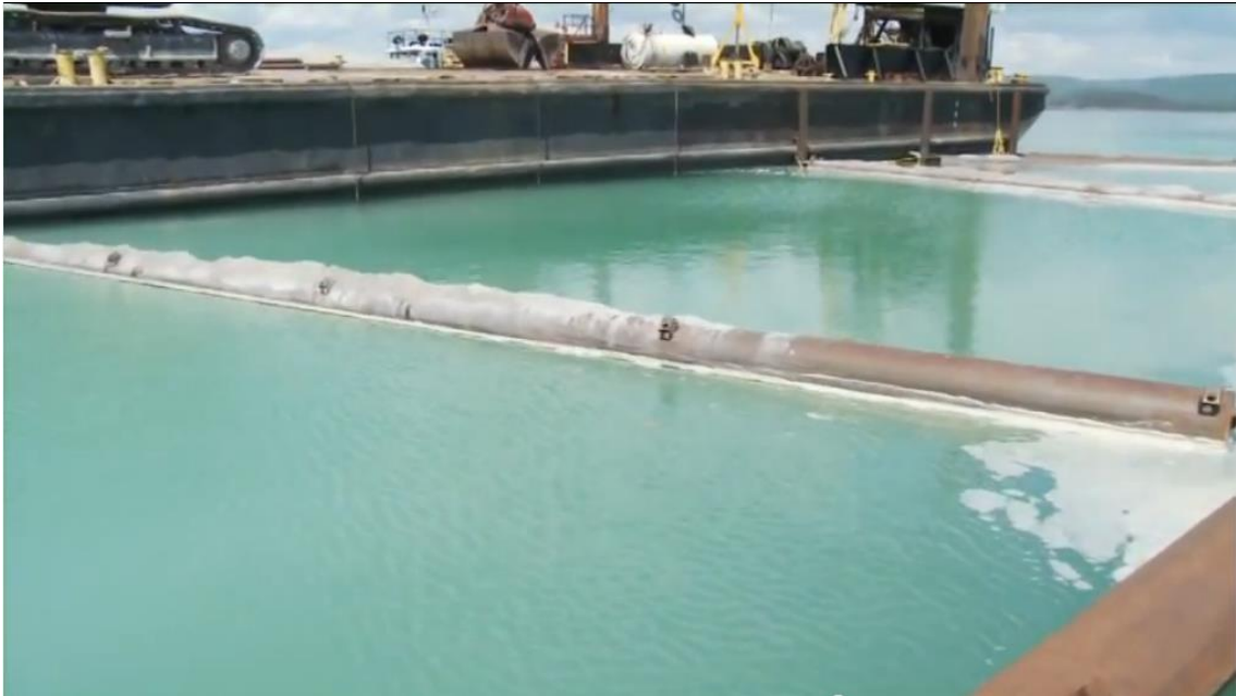
Figur 17. Bildet viser hvordan lekteren har soner avgrenset av siltskjørt noe som bidrar til god kontroll på utleggingen av tildekkingsmaterialet.
