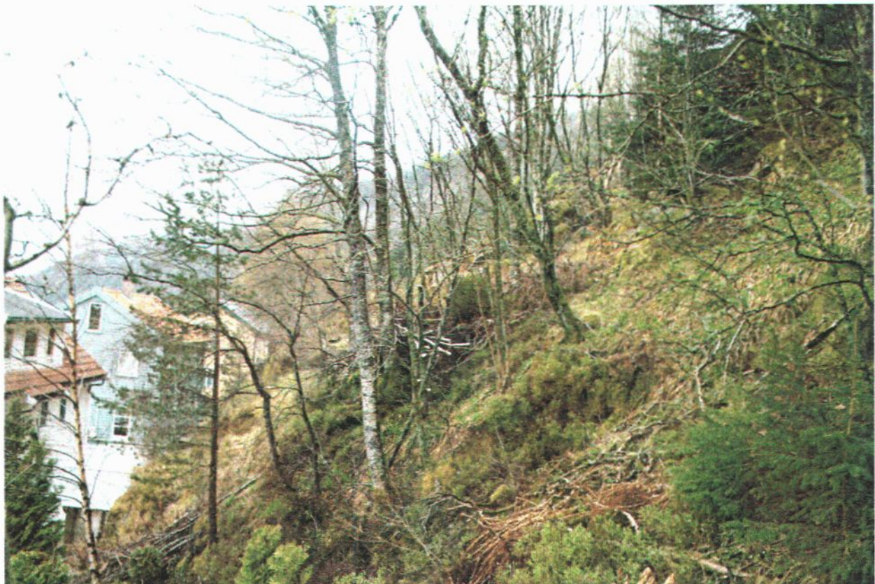
Bilde 2 Skråning bak nummer 23. Fjellet er dekket med et tynt løsmassedekke og spredt vegetasjon, videre opp blir det bart fjell.
