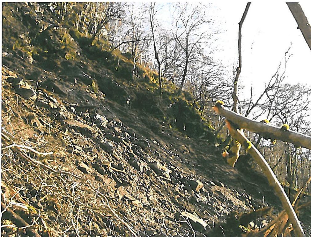
Bilde 5: Viser deler av skredgropa.
