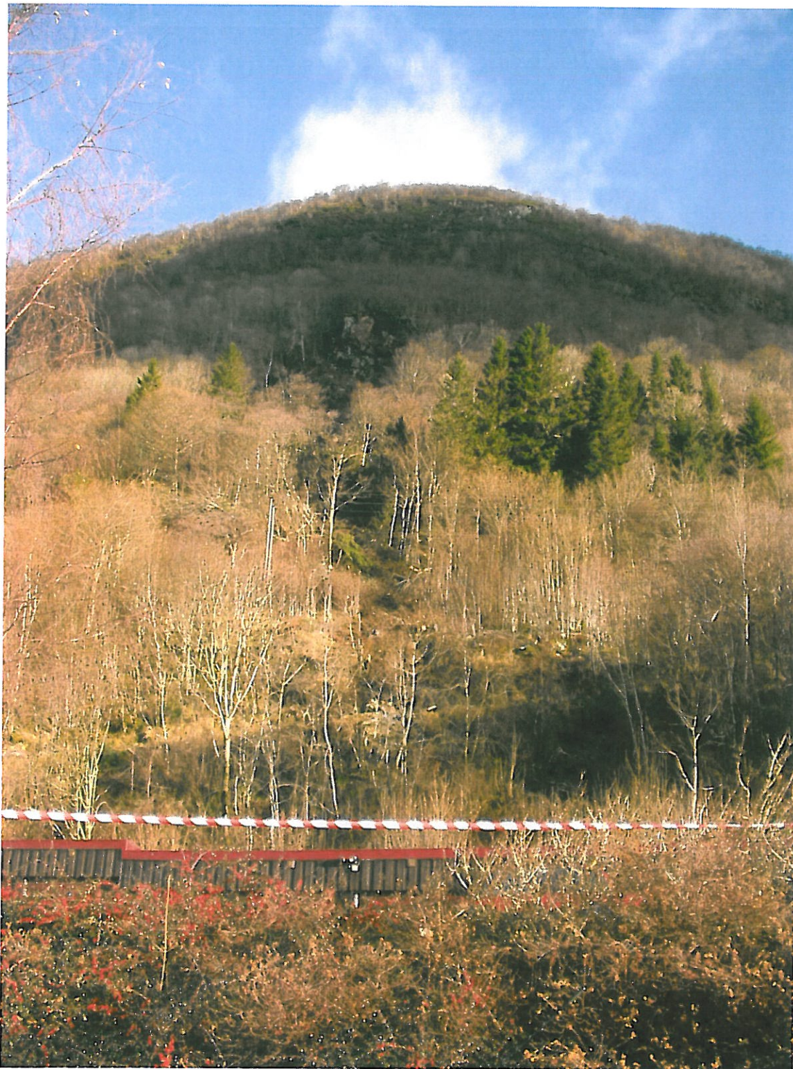
Bilde 1: Viser bergpartiet med løseområdet, skråningen med ura og skredbanen ned mot vegen og garasjene.
