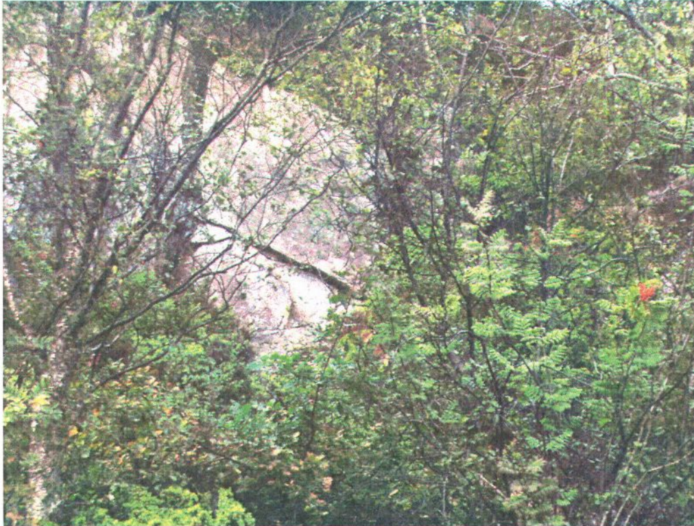
Bilde 3: Viser stor løs blokk ovenfor bolig.
