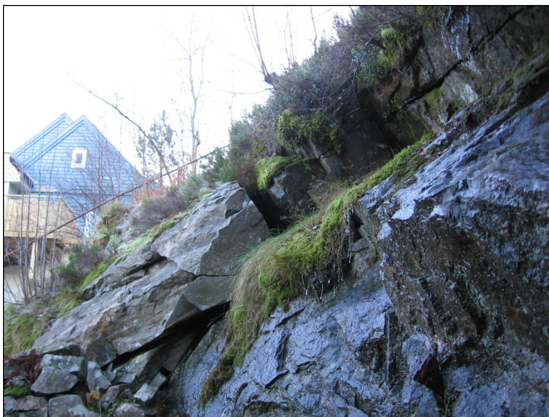
Figur 2 Avløst blokk i skjæring.
