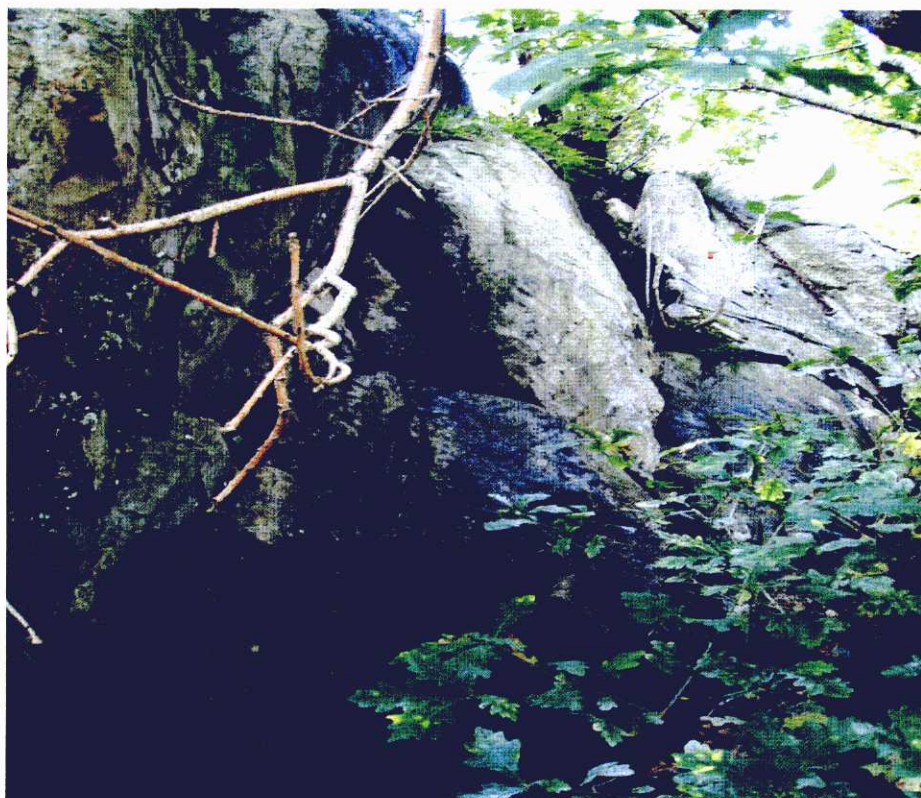
Bilde 5: Blokker ovenfor Mathopsveien 45. Øverst til høyre blokk sikret med kjetting
