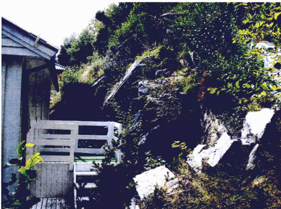
Bilde 2: Fjellparti bak Mathopsveien 41
