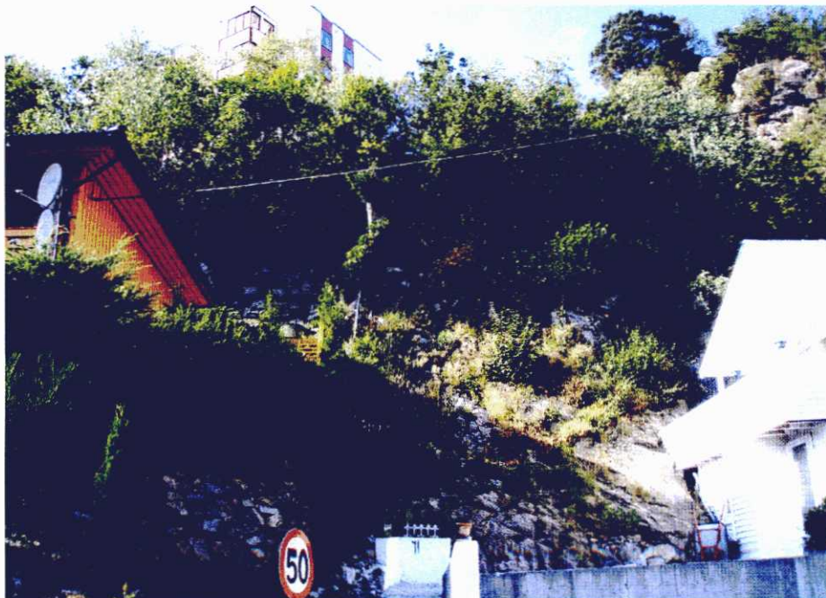
Bilde 4: Området mellom Mathopsveien 41 og 43. Pil viser kloakk - kum
