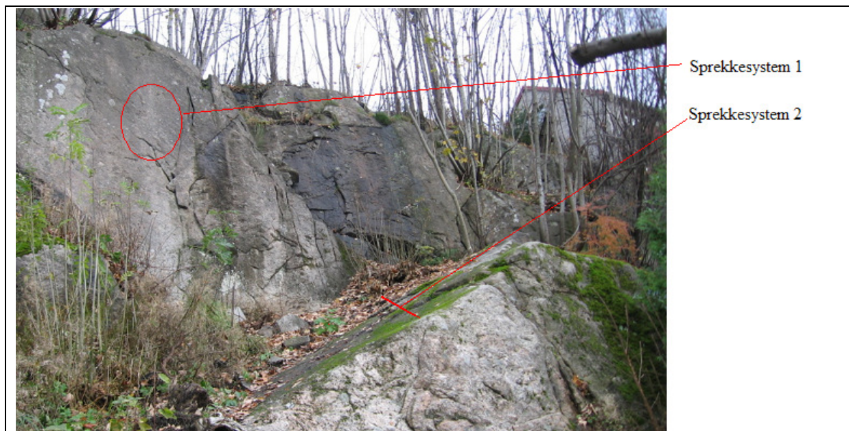
Figur 3 Bildet viser de to sprekkesystemene i form av sprekkeflater.
