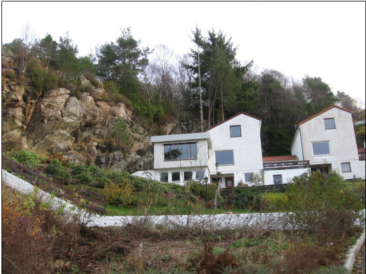
Figur 2 Oversiktsbilde Helleveien 241 og 249.
