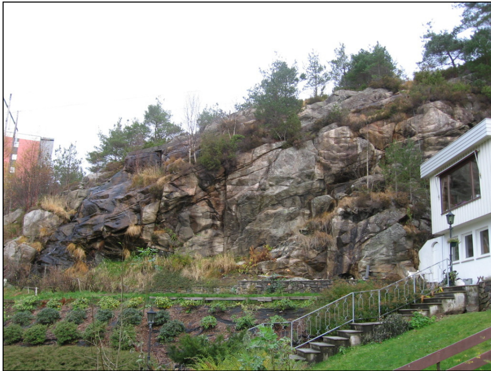
Figur 3 Bergvegg nordvest for Helleveien 251.
