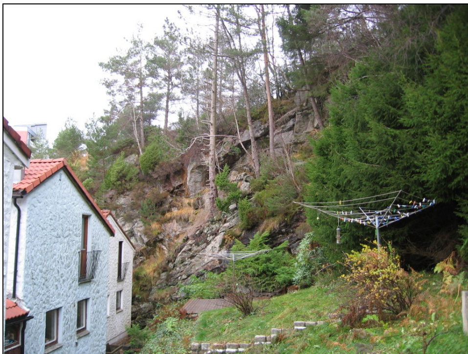
Figur 4 Bergvegg bak Helleveien 249 og 251.
