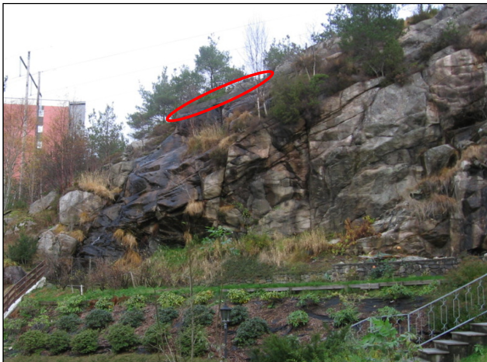
Figur 7 Mur etablert for å lede bekk ut til siden.
