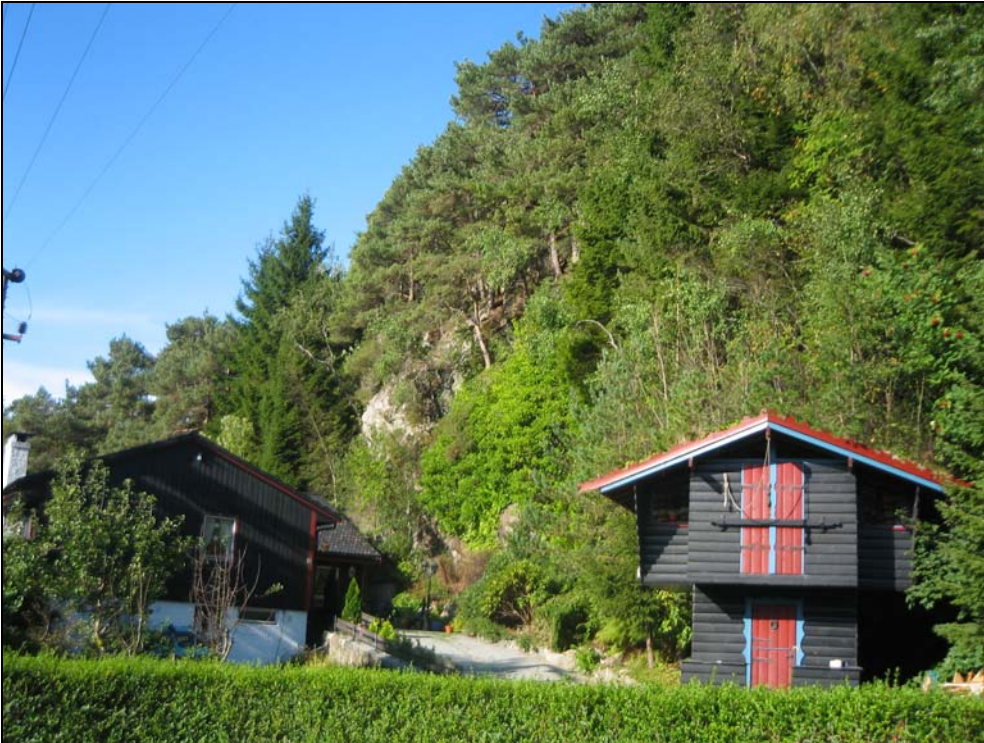
Figur 2. Haukedalsveien 43 med bakenforliggende bergvegg.
