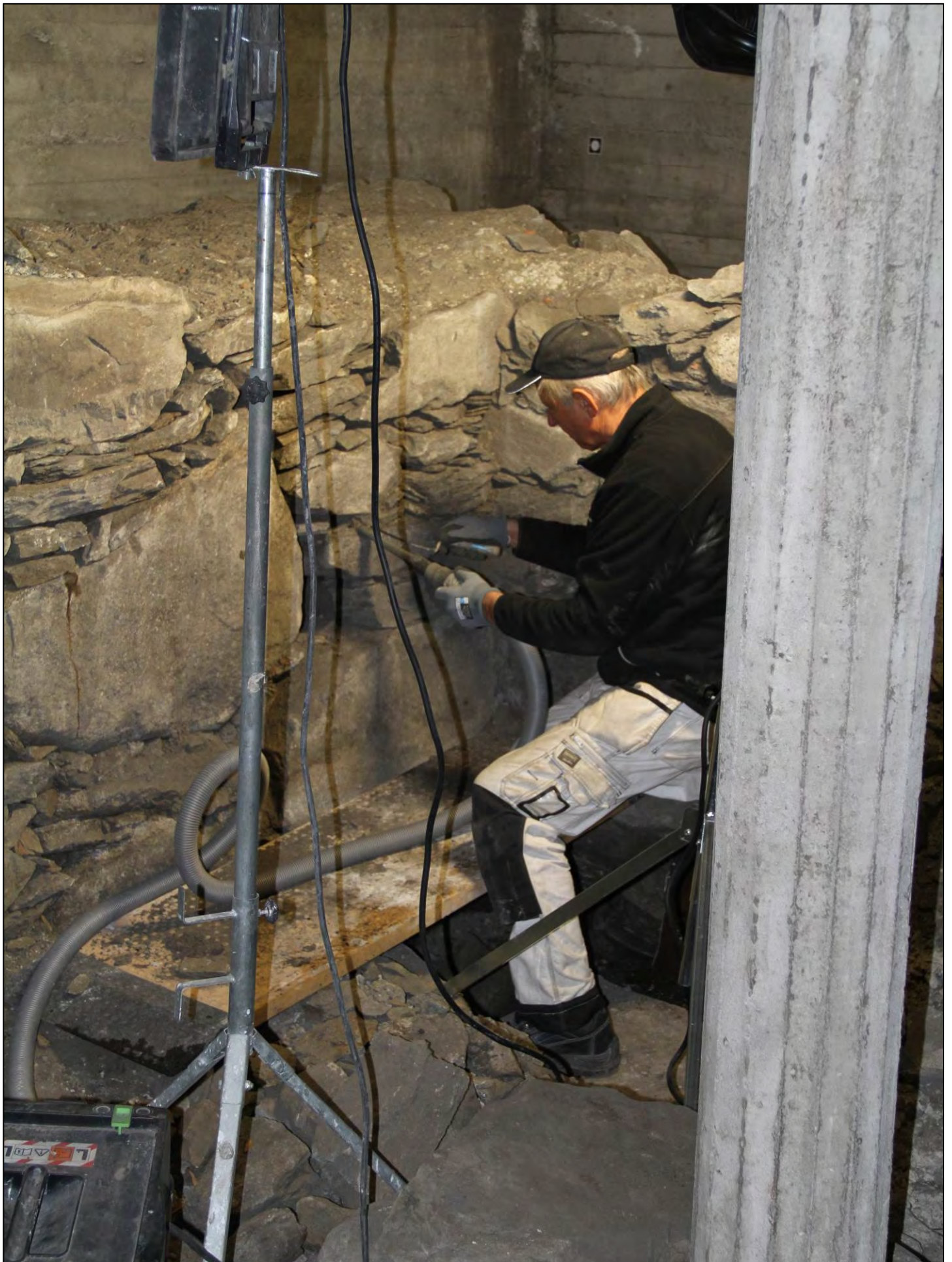
Figur 2: Tidlig i konserveringsprosessen. Murer Arvid Grindheim (Akasia) renser murverket for løsmasser (Foto: Bergen kommune, Byantikvaren 2012).
