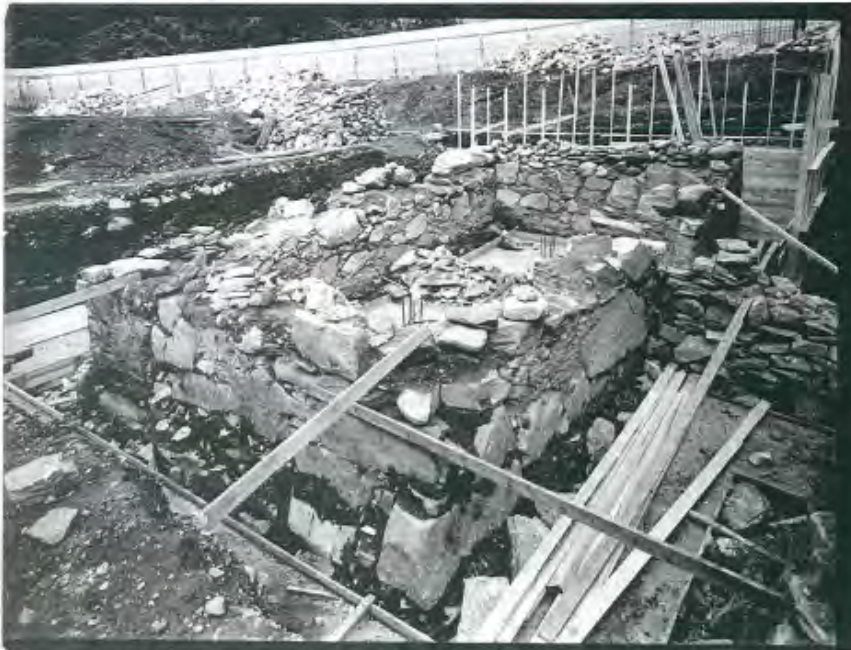
Historisk foto som viser noe av omfanget av inngrep i og rundt ruinen i forbindelse med den arkeologiske utgravningen og ved oppføringen av betongkjelleren som ruinen er omkranset av i dag. Bildet er hentet fra en serie på ca. 10 bilder fra utgravningen i 1935. Originalfotoene befinner seg ved Hanseatisk Museum.
