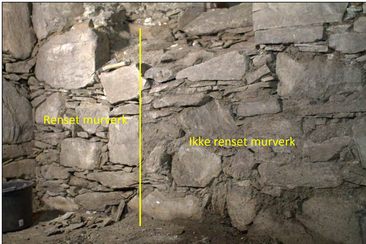
Figur 13: Del av sørmurens indre murliv, øst for portal. Eksempel fra prosessen med å rense murlivene for jord (Foto: Byantikvaren, Bergen kommune 2012).
