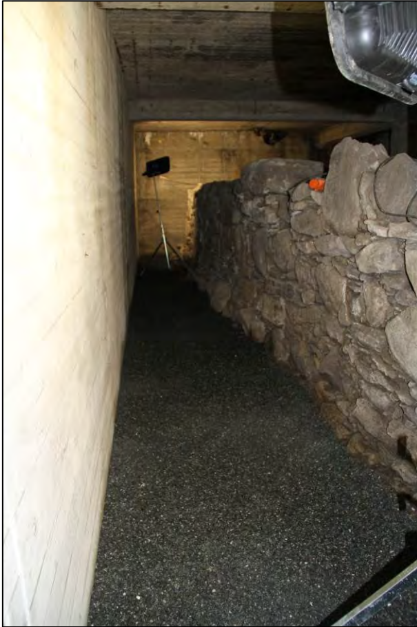
Figur 20: Langs ytterlivet av nordveggen ble grusen lagt over betonglaget. Grusen ble lagt slik at gulvnivået ble vattret (Foto: Bergen kommune, Byantikvaren 2013).
