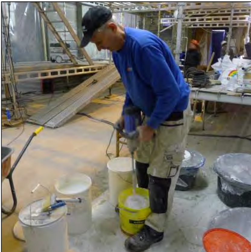
Figur 16 (venstre): Bearbeiding av kalkdeig til en smidig konsistens inne i Mariakirken (Foto: Byantikvaren, Bergen kommune 2012).
