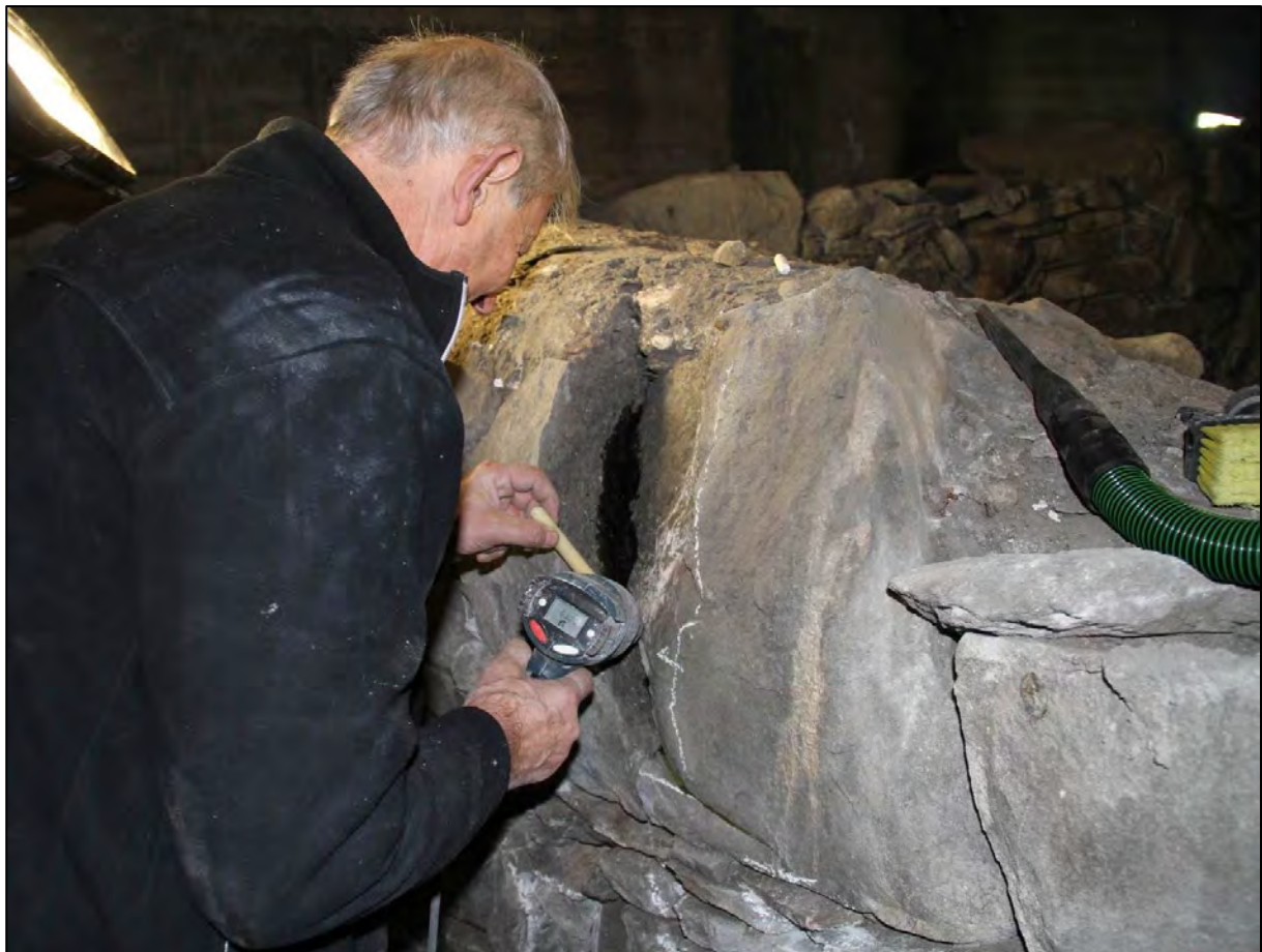
Figur 18: Murer Arvid Grindheim limer stein ved hjelp av steinlim og varmpistol (Foto: Bergen kommune, Byantikvaren 2012).
