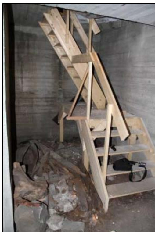
Illustrasjon 27 (høyre): Midlertidig trapp fra Dramshusens schøtstue ned til forrommet til ruinene (Foto: Byantikvaren 2011)
