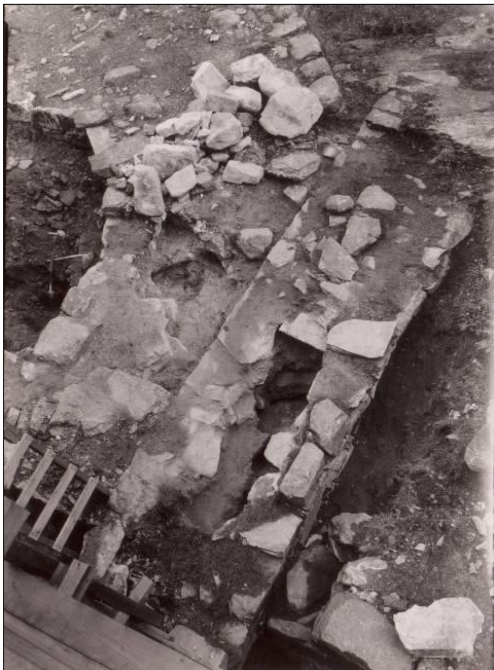
Figur 47: Foto fra utgravingene i 1952 viser tydelig at den sørligste halvdelen av muren er en selvstendig kistemur, og at den nordlige delen av muren er murt inntil sørdelen (Fischer 1952).
