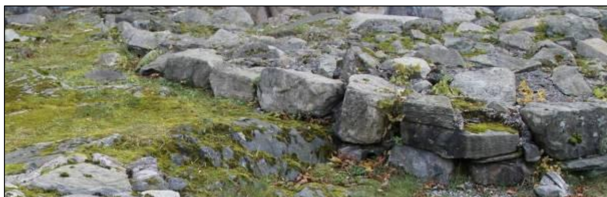
Figur 43: Foto av sørøstre ytterliv R1-4 (Foto: Byantikvaren 2011, mot NV).
