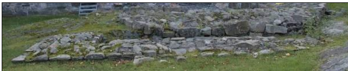
Figur 12: Foto av ytterlivet i S2 (Foto: Byantikvaren 2011, mot SV).
