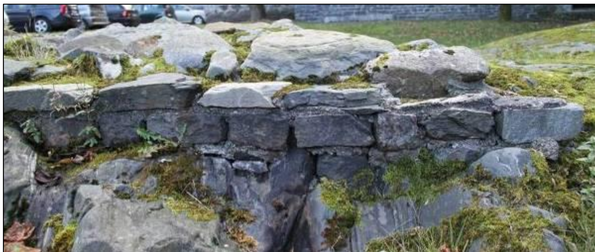
Figur 23: Foto fra innerlivet i S3. De brosteinslignende steinene er murt rett på fjellgrunn med sement (Foto: Byantikvaren 2011, mot SØ).
