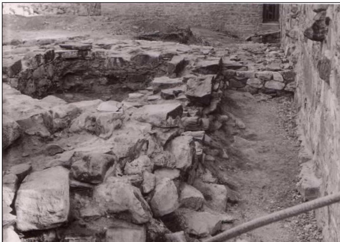
Figur 59: Foto fra 1962 som viser at muren da hadde tre skift. Det øvre skiftet mangler i dag. Ellers ser steinene ut til å samsvare med dagens situasjon (Foto: Fischer 1962, mot SØ).
