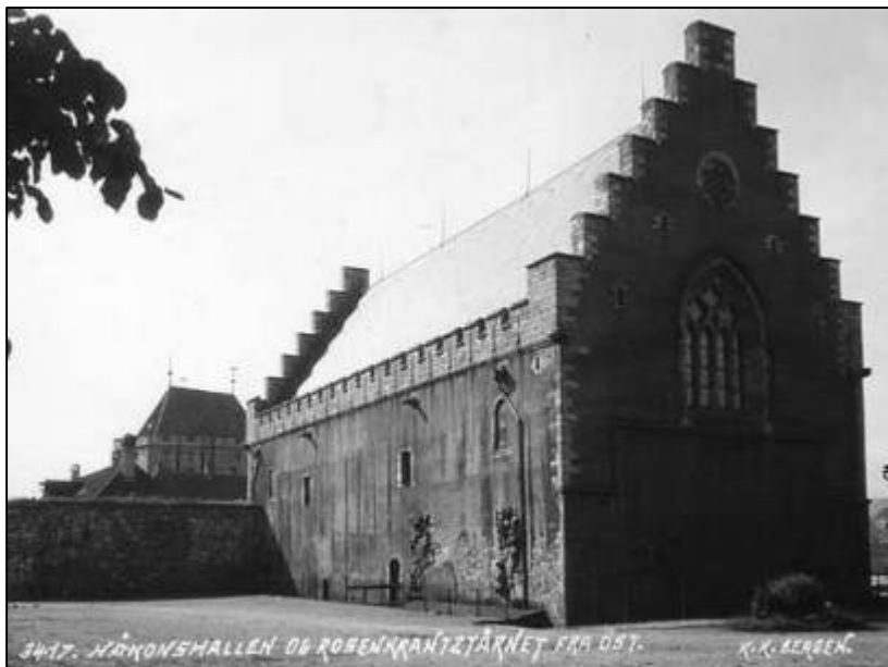
Figur 64: Foto fra østsiden av Håkonshallen fra 1930-39 som viser en løsning på å lede vekk takrennevann fra den nordligste spylereennen (Billedsamlingen, UiB).
