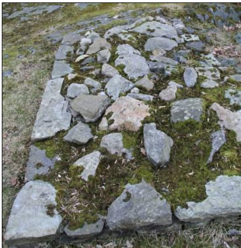
Figur 25: Foto fra murkronen på S3 (Foto: Byantikvaren 2011, mot SV).
