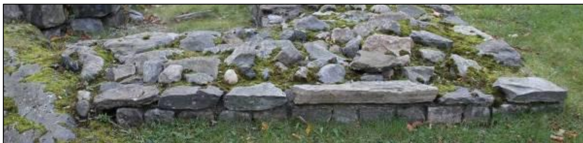
Figur 24: Foto fra ytterlivet i S3. De brosteinslignende steinene er murt rett på fjellgrunn med sement (Foto: Byantikvaren 2011, mot NV).
