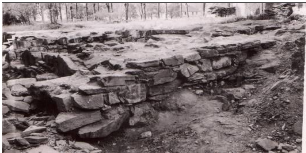
Figur 45: Foto fra utgravningene i 1962. Bildet viser et murverket R1-5 nesten ikke har igjen mørtel i fugene (Foto: Fischer 1962, mot N).
