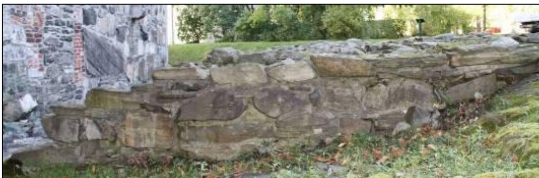
Figur 46: Foto av ytterlivet R1-5 (Foto: Byantikvaren 2011, mot N).
