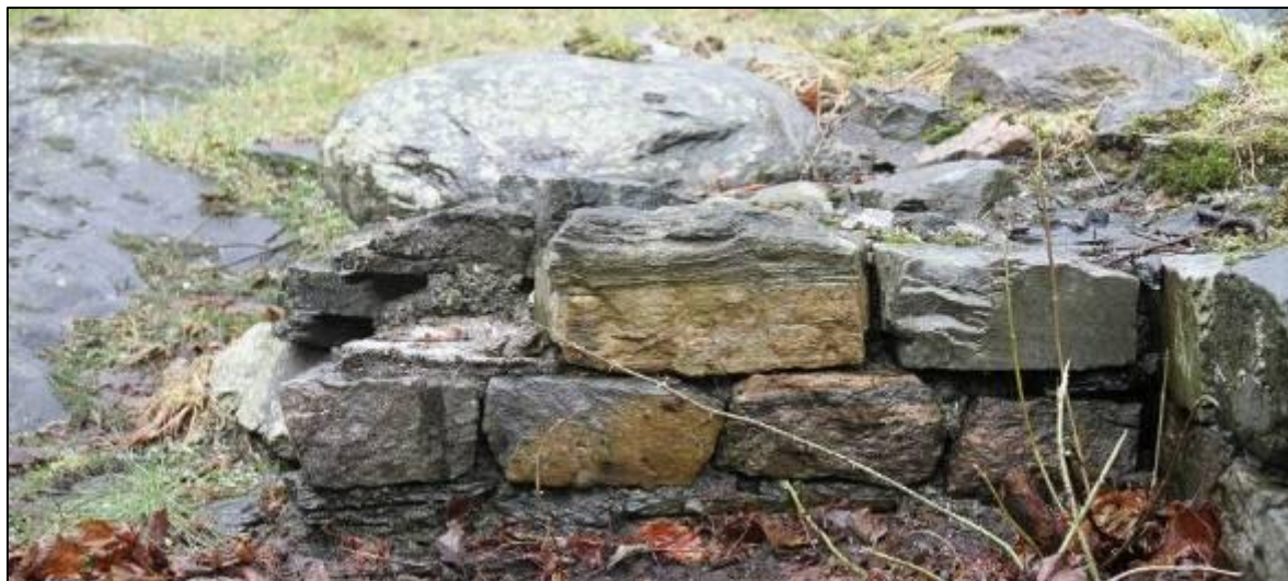
Figur 17: Foto fra innerlivet i S1, viser at muren er ført opp av brosteinslignende steiner på en skiferhelle (Foto: Byantikvaren 2011, mot NV).
