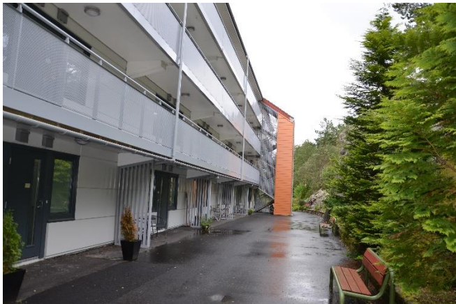
Svalgang med trapperom i Sandsli borettslag Foto: Kari Ingvaldsen
