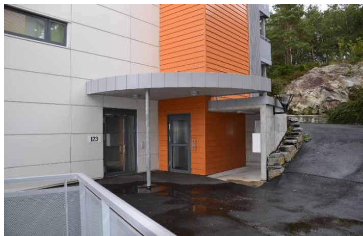
Inngangsparti med heis og nytt postrom Foto: Kari Ingvaldsen
