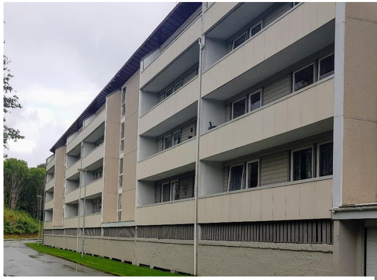
Oppganger og garasjeanlegg i Tjønneveien borettslag Foto: Ingerd Lene Nyheim
