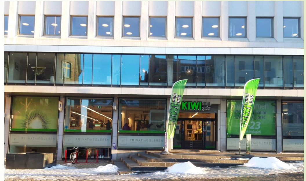
Vimpler og helfolierte vinduer
