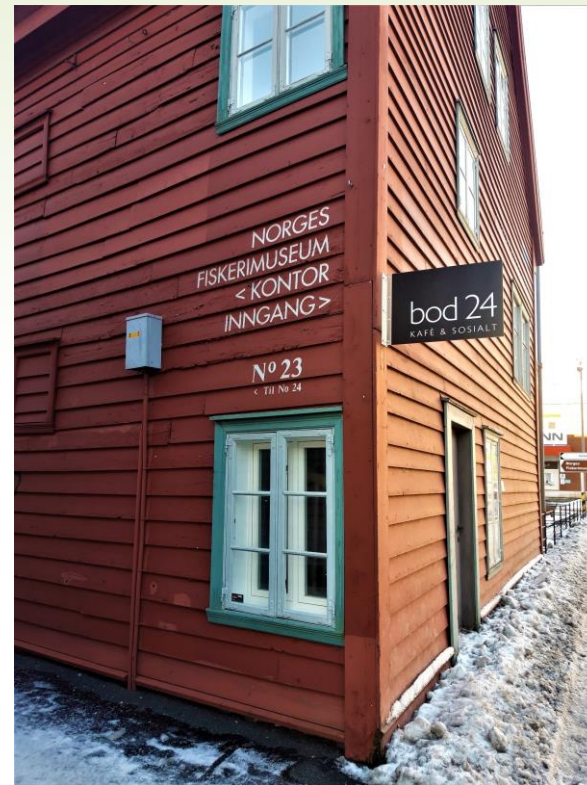
Uthengsskilt er festet tett inntil vegg
