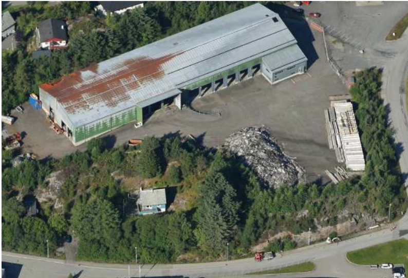
Figur 7: Skråfoto av byggene som ligger på kvartals-ID 18. Bildet er tatt fra øst. Kilde: Gule sider.
