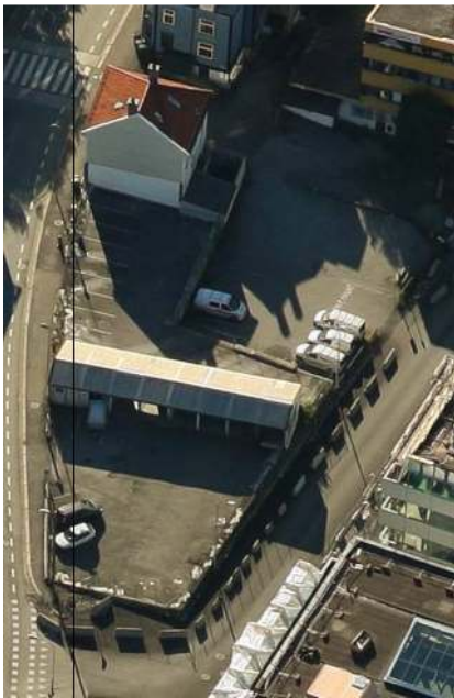
Figur 48: Skråfoto av byggene som ligger på kvartals-ID 92. Bildet er tatt fra øst. Kilde: Gule sider.
