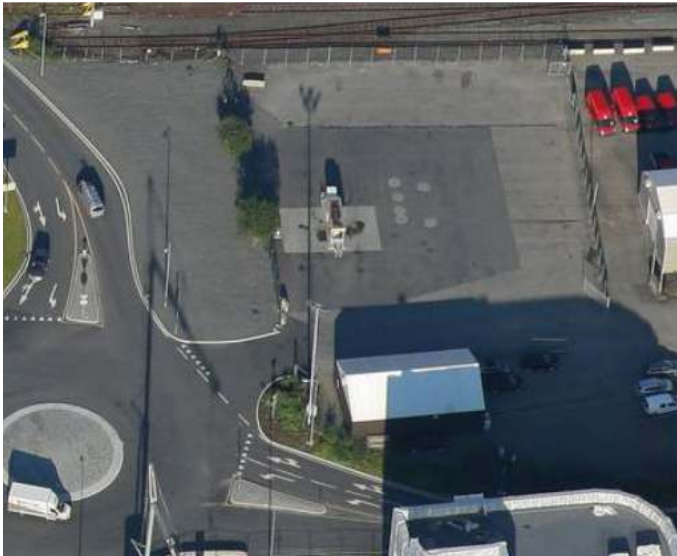
Figur 42: Skråfoto av byggene som ligger på kvartals-ID 82. Bildet er tatt fra øst. Kilde: Gule sider.
