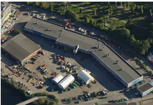
Figur 51: Skråfoto av byggene som ligger på kvartals-ID 7. Bildet er tatt fra nord. Kilde: Gule sider.
