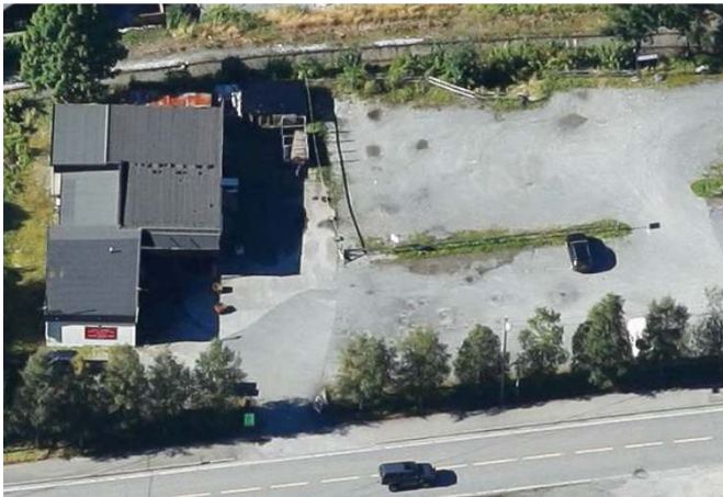
Figur 71: Skråfoto av byggene som ligger på kvartals-ID 130. Bildet er tatt fra øst. Kilde: Gule sider.
