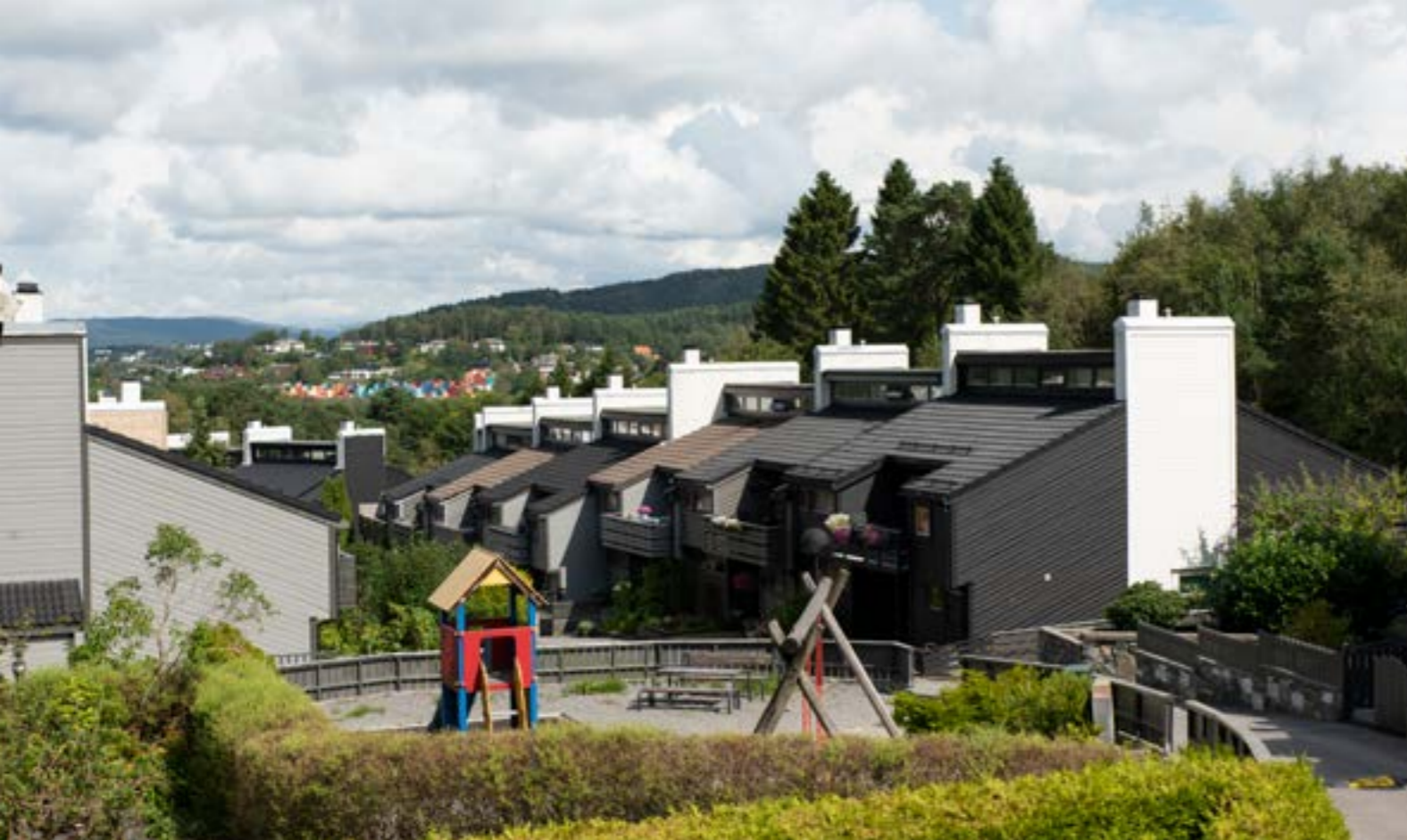
Ulsetskogen ble helhetlig planlagt og regulert med fokus på fellesfunksjoner med kantsoner og uteareal. Bygningsrekkene "klatrer" svakt langs terrenget og er sakset i forhold til hverandre. Selv om rekkehusene er like, oppleves området som variert og mangfoldig. Ulsetskogen er tegnet og planlagt av arkitekt Helge Hjertholm,
