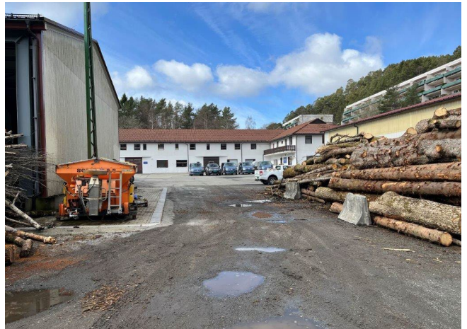
Figur 33 - Lagerhall til venstre og kontorbebyggelse øverst.
