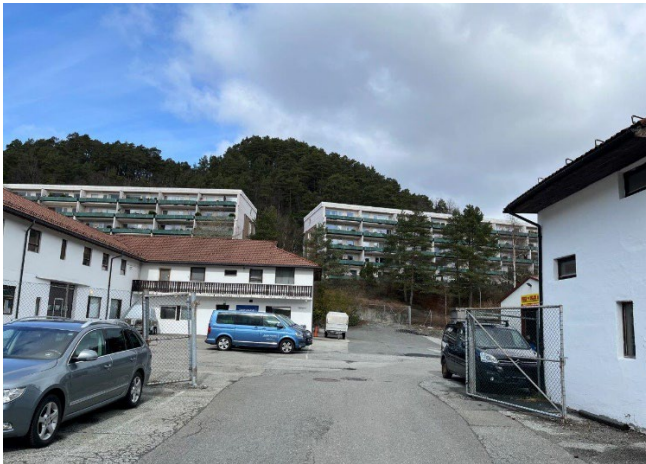
Figur 32 - Kontorbebyggelse i øvre del av planområdet.
