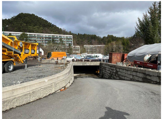
Figur 38 - Nyere parkeringskjeller øst i byggeområdet mot Lauvåstjørna.
