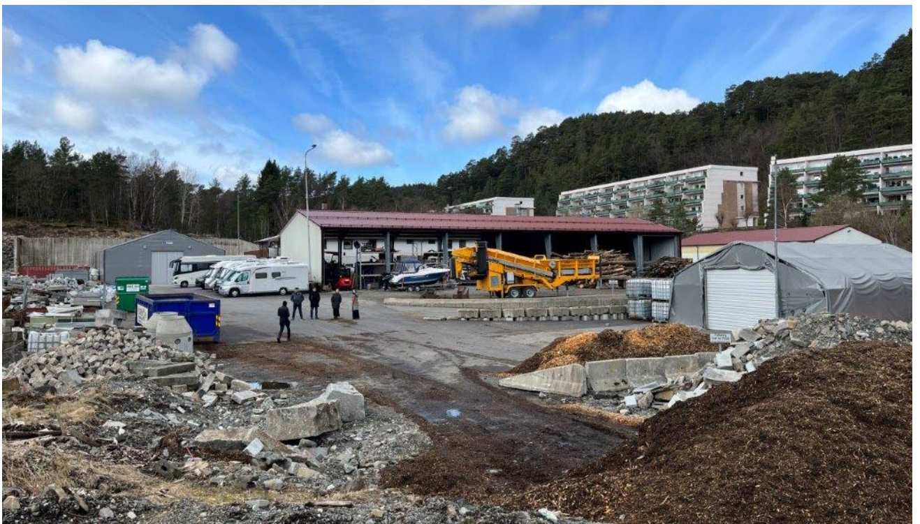
Figur 34 - Fjellskjæring til venstre, lager midt i bildet, og nyere parkeringskjeller til høyre.
