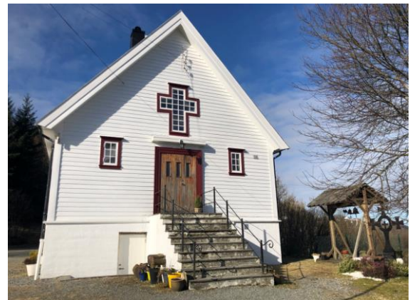
Figur 4-6 Inngang på østsiden med korsformet vindu.
