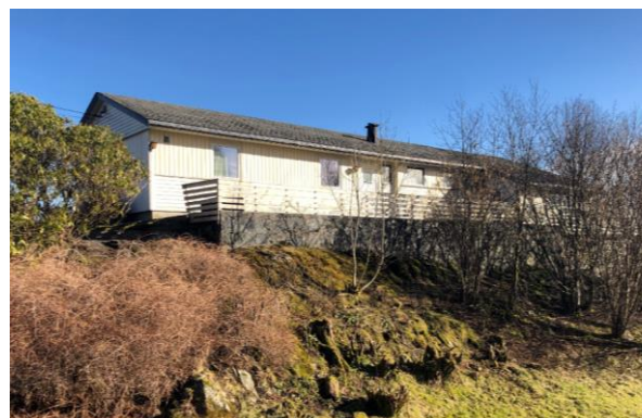
Figur 4-23 Bolig i Ytrebygdsvegen 81 sett mot nordøst.
