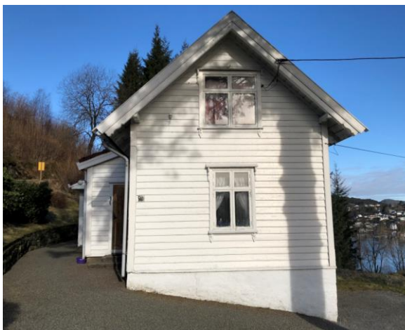
Figur 4-11 Sett mot nord.
