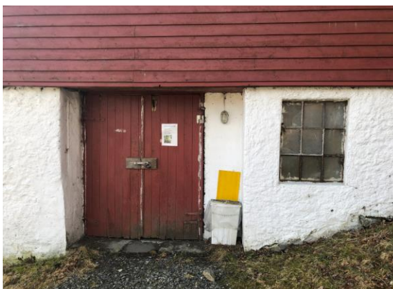
Figur 4-17 Detalj dør og vindu på nordsiden.
