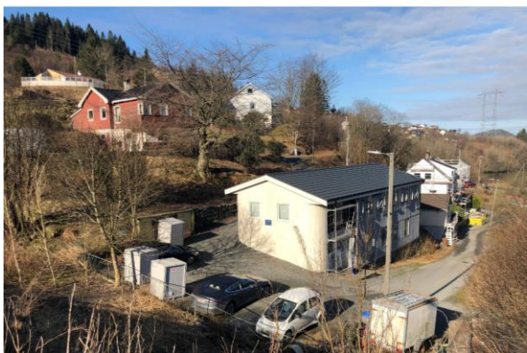
Figur 4-24 Kontorbygning i Grimstadvegen 24 sett mot nordvest.
