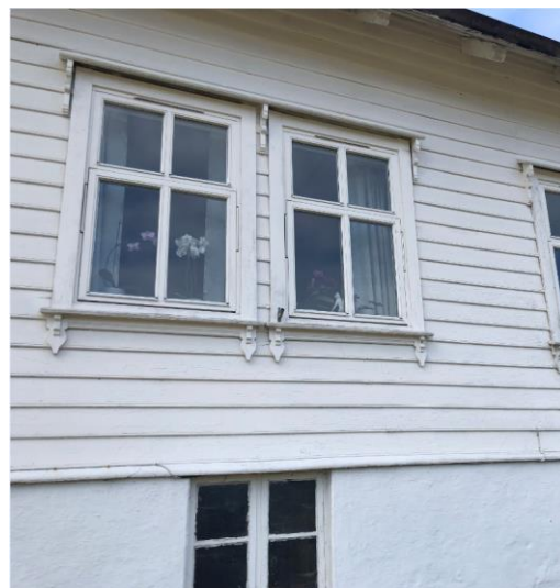
Figur 4-14 Vinduer med dekor på østsiden.
