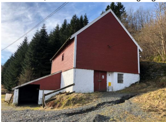
Figur 4-15 Driftsbygning sett mot sør.
