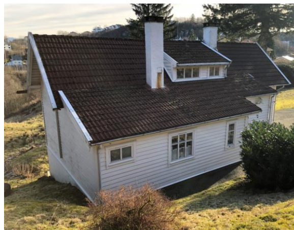
Figur 4-12 Teglsteinstak sett mot øst.
