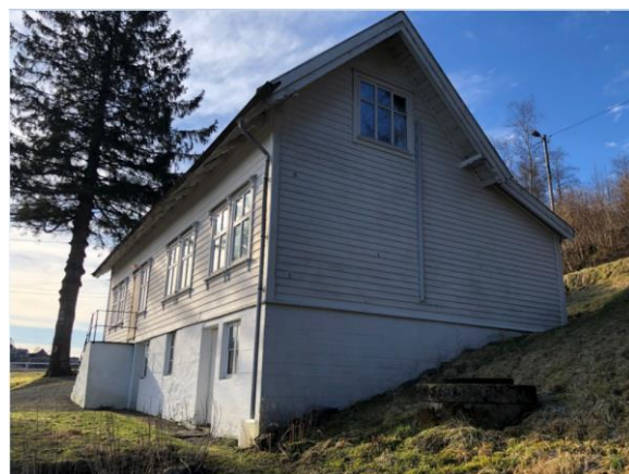
Figur 4-10 Sett mot sør.
