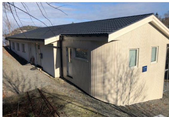
Figur 4-25 Kontorbygning i Grimstadvegen 24 sett mot nord.
