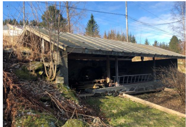
Figur 4-36 Uthus vest for boligen sett mot nordvest.
