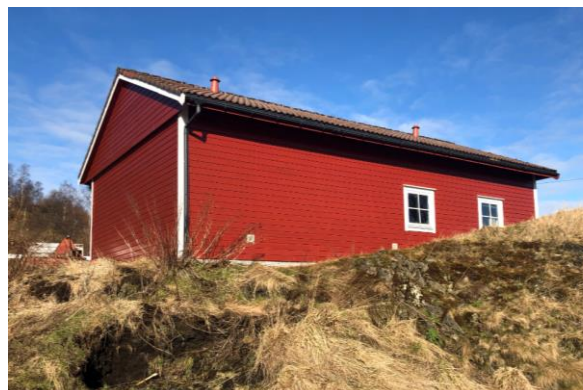
Figur 4-30 Nyere garasje sør for boligen, sett mot nordvest.
