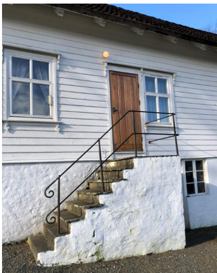
Figur 4-13 Inngang med murtrapp, skiferheller og enkelt støpejernsrekkverk på østsiden av huset.
