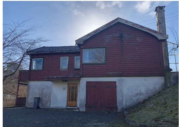
Figur 4-34 Sett mot sør.
