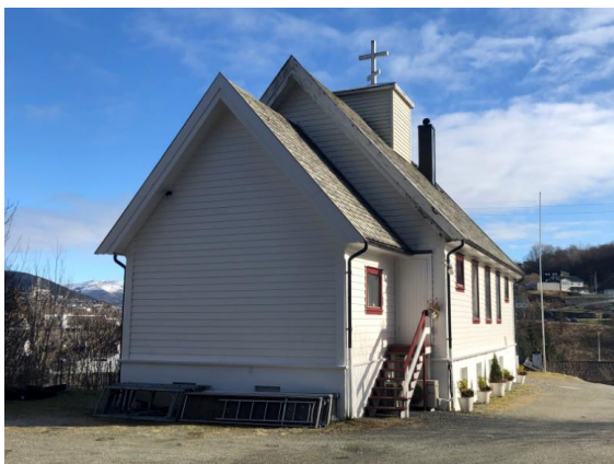
Figur 4-7 Bedehuset sett mot nordøst.
