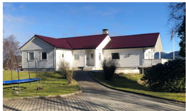
Figur 4-21 Bolig i Ytrebygdsvegen 79 sett mot nord.
