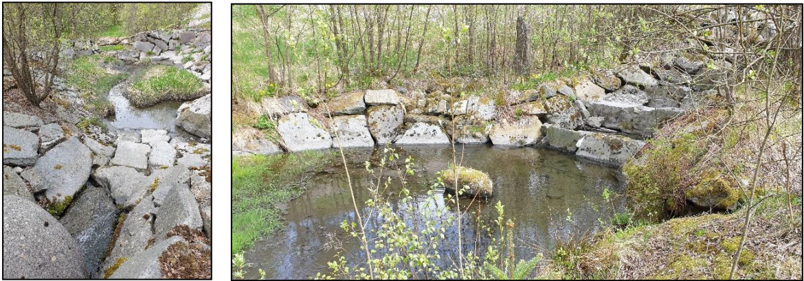
Figur 5 Flomsikring i øvre deler av bekken (t.v.: nedstrøms, t.h.: oppstrøms). Foto: Magnar Bjerga, Multiconsult.
