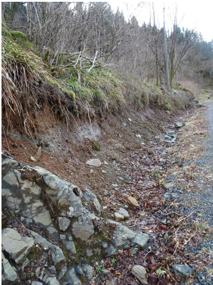
Figur 13. Grøft mellom veiskjæring og vei som samler eventuelt nedfall av jord og stein.
