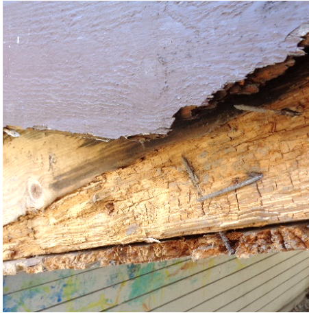
Figur 6: Utstikkende spikre på lekehus.
