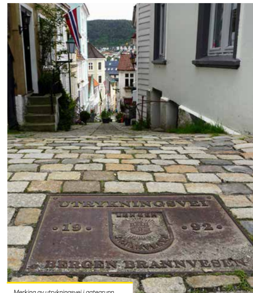
Merking av utrykningsvei i gategrunn.
