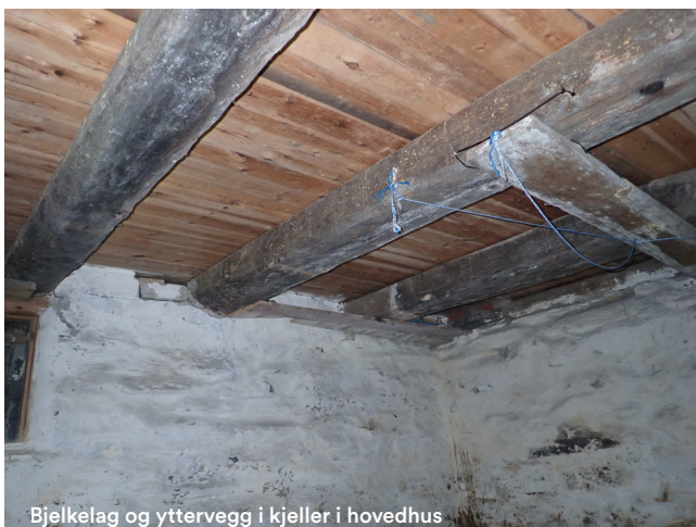
Soppvekst på alle overflater i hovedhus.
