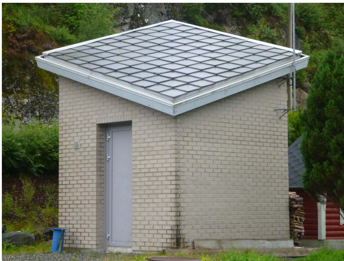
Figur 2: Pumpestasjon for spillvann ved Lonemyra.
