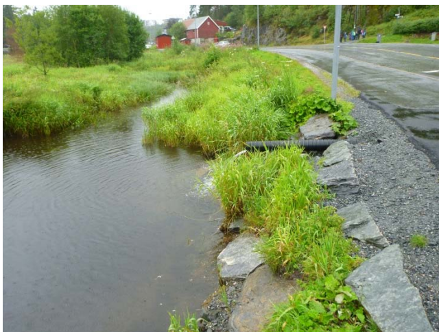
Figur 4: Betongrør for Sandalselva ligger under vannspeilet
