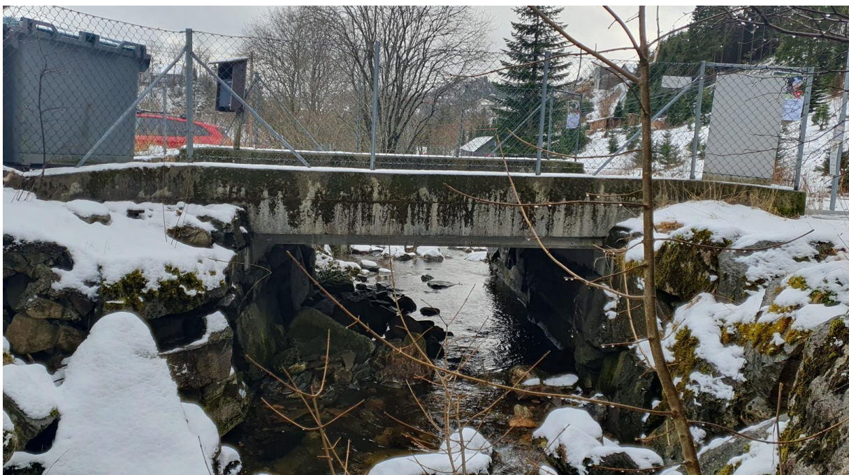
Figur 4: Bru 2 har lysåpning på 3 x 1,4 m. Landkar i tørrmur. Flomvei vurdert til ut over høyre bredde.
