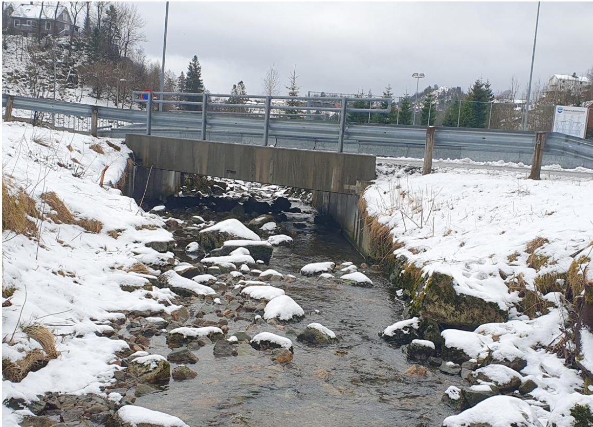
Figur 6: Bru 4 har lysåpning på 5 x 1 m. Landkar i betong. Flomvei vurdert til noe diffus, men trolig ut over venstre bredde. Elveløpet innsnevres nedstrøms brua pga. tørrmur som er lagt i vinkel inn mot senter av elva fra høyre bredde.
