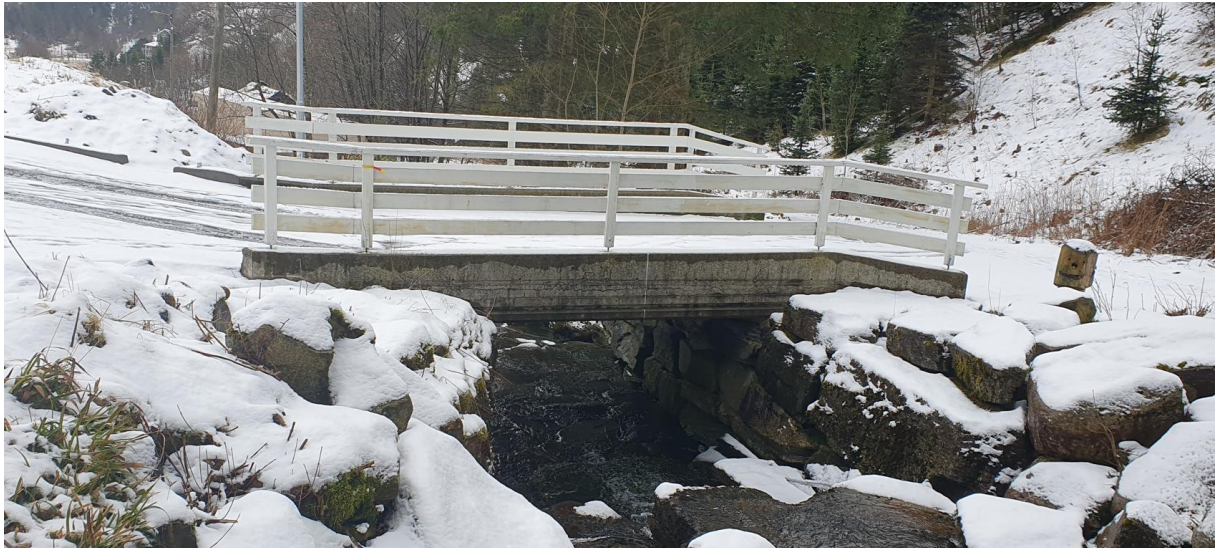
Figur 3: Bru 1 har en lysåpning på 3,3 x 2 m (horisontal x vertikal). Landkar i tørrmur. Flomvei vurdert til ut over høyre bredde.
