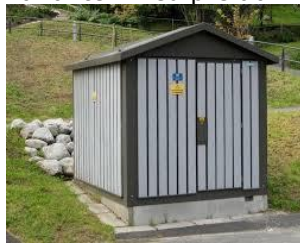
Figur 1 Frittstående nettstasjon(eksempel)
