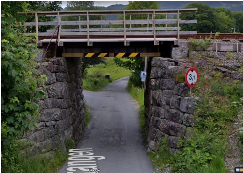
Figur 1: Kulvert slik den ser ut i dag, ref. Google Maps.
