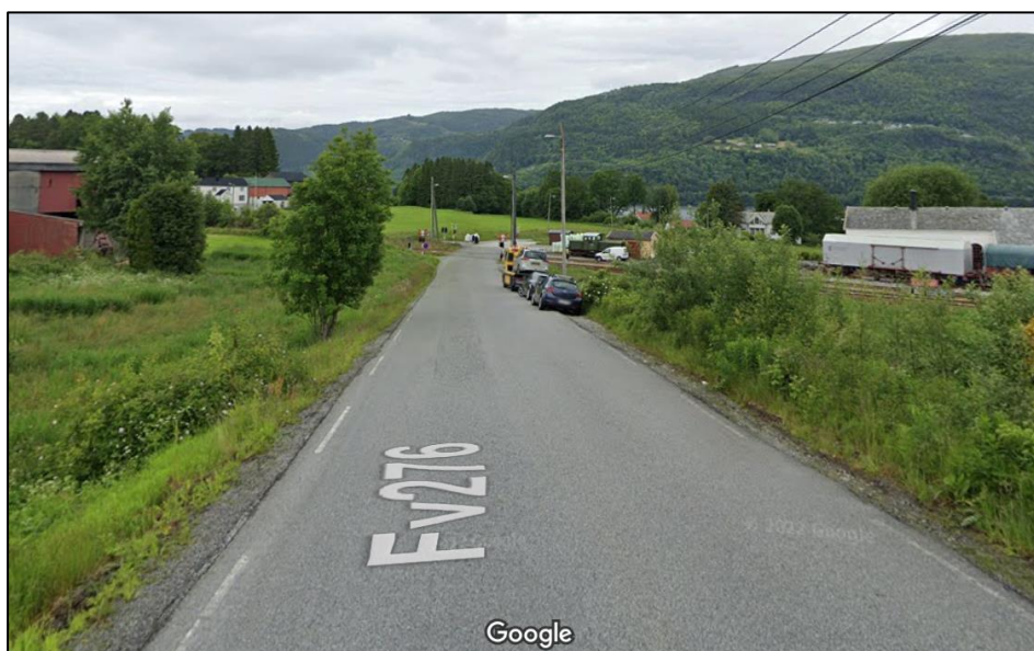
Figur 2: Dagens tilstand og bruk av Garnesvegen. Kilde: Google Maps.
