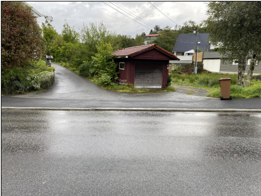
Figur 6. Dagens tilkomst til eiendommene Hjortevegen 4 og 6 (avkjørsel til venstre i bildet). Avkjørselen til Hjortevegen 6a (til høyre for garasjen) ligger utenfor planområdet.
