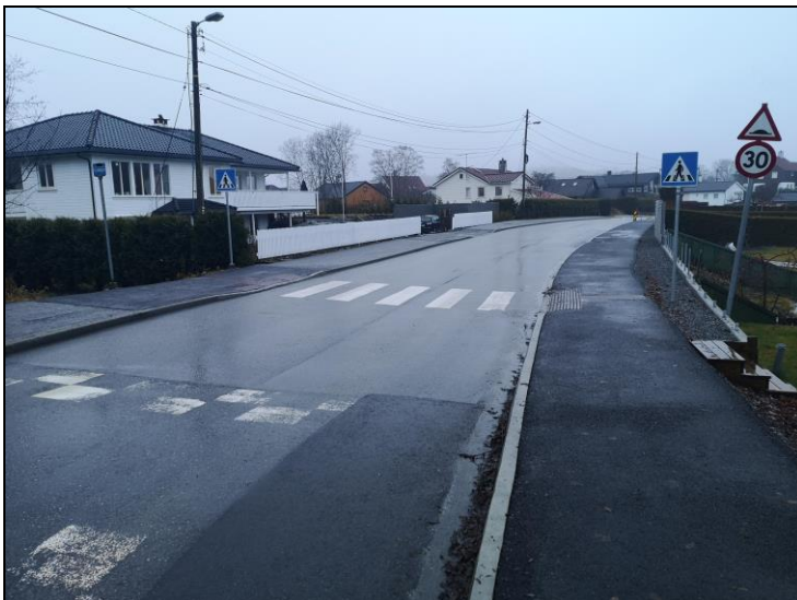
Figur 14. Hjortevegen har 30 km/t, fysisk fartsdemping (humper) og tosidig fortau.
