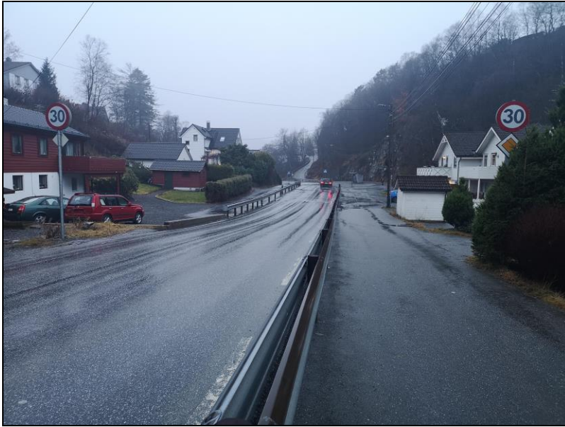
Figur 15. Apeltunvegen har delvis 30 km/t og 40 km/t som fartsgrense, og sammenhengende fortau eller gang/sykkelveg som på deler av strekningen er adskilt fra kjørebanelen med autovern.
