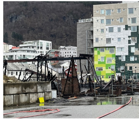
Figur 2 Situasjonen etter brannen.
