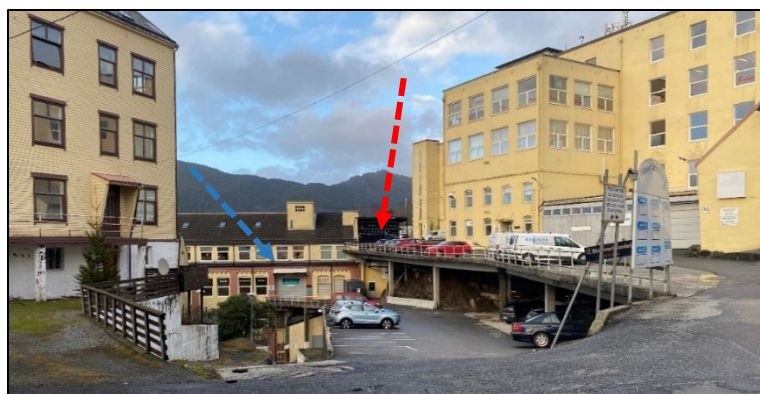
Figur 2: Næringsavfallet plasseres i bossrom i WHV33, fram til det hentes (rød pil). Varelevering til Berle Møbler skjer i etg. Under (blå pil). Foto: Vill Plan
