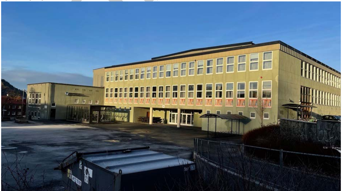
Figur 10 Langhaugen skole, fasade mot sør, og øvre skoleplass. (foto: ORA)
