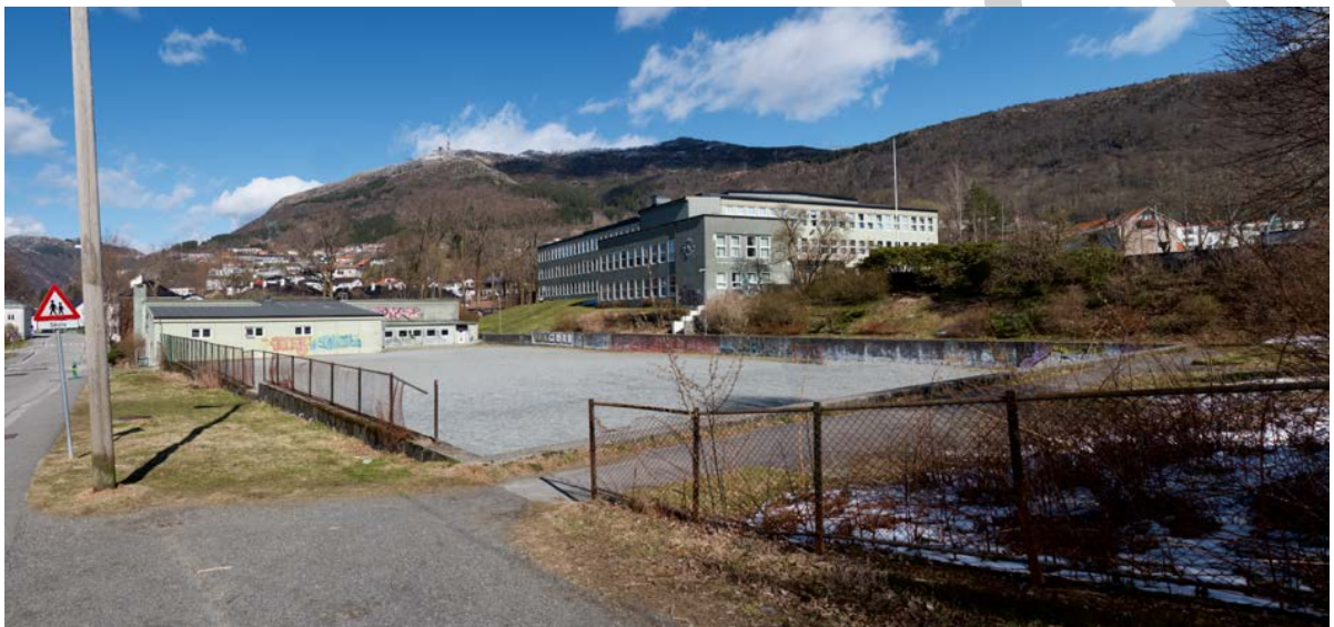
Figur 9 Langhaugens skole sett fra Slettebakksveien i sørvest. Gymsalen til venstre i bildet (foto: ORA)
