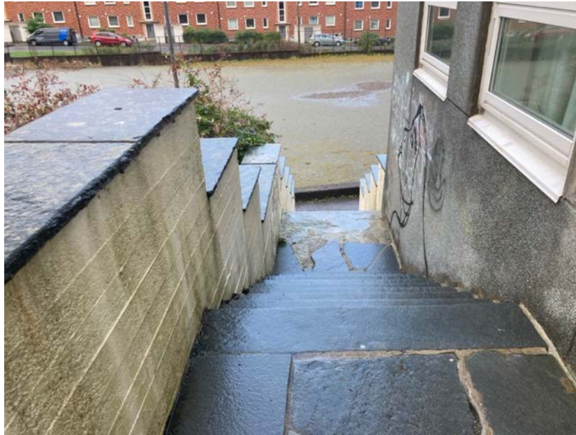
Figur 24 Kobling mellom skole og gymsal er ikke universelt utformet. (foto: ORA)
