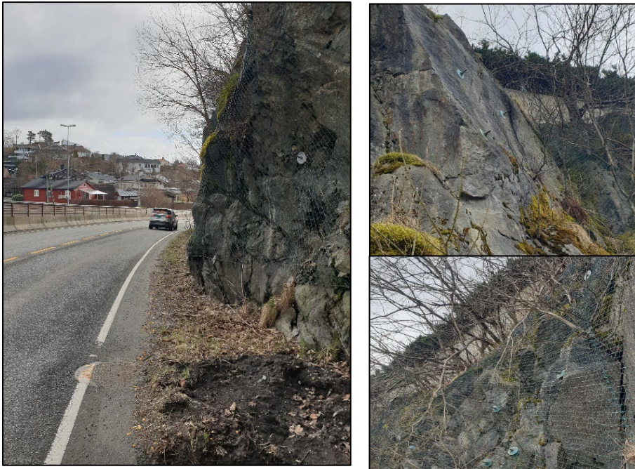
Figur 8 Eksisterende fjellskjæring langs Fv Steinsvikvegen
