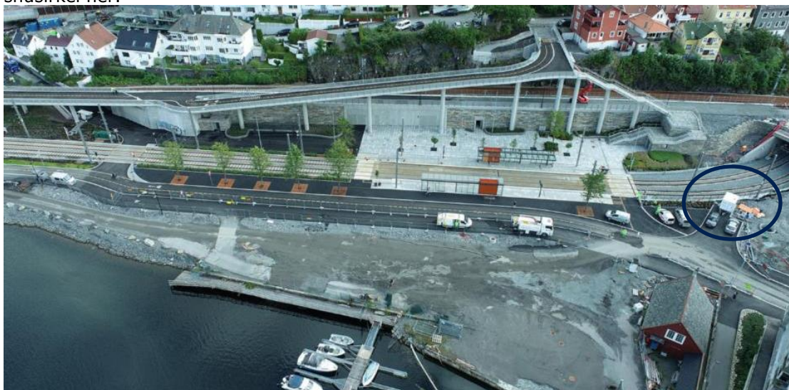
Figur 36: Bildet viser oversikt over det nye bybanestoppet og områdene rundt inkl. snuhammer og parkeringsplass i bakkant (ringet ut i svart).
