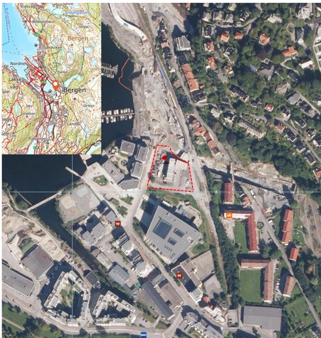
Figur 1: Flyfoto fra 2020 av tomten hvor Griegakademiet skal bygges (rødstiplet linje) [3] [4]
