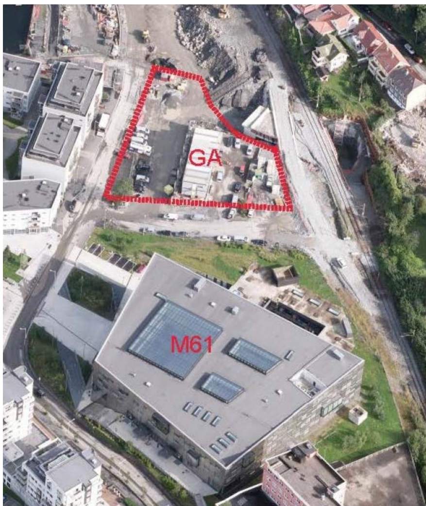
Figur 2: Bilde av tomt for Griegakademiet (GA) i Møllendalsveien 69 og Fakultet for kunst, musikk og design (KMD) i Møllendalsveien 61 (M61). Kilde: Kravspesifikasjon totalentreprise [1]
