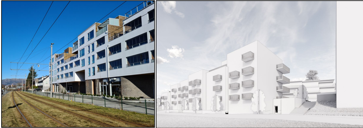
Figur 89. Venstre: Dagens situasjon langs Fanavegen, planområdet i bakgrunnen. Høyre: Nytt tiltak, Sætervegen 4 skimtes til høyre.
