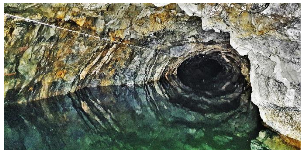
Figur 2: Et bergsprengt drikkevannsmagasin/høydebasseng inneholder rent vann fra vannbehandlingsanlegget. Vannet får ikke videre behandling før det leveres til abonnentene.
