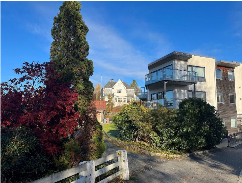
Innkjøring til Sundts veg 5. Nestunvegen 101A ses i midten og Sundts veg 3 ses til høyre i bildet.
