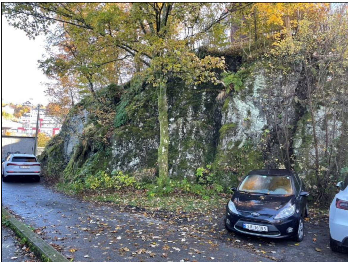
Figur 5. Bergskrenter i nordøstlig del av kartleggingsområdet. Skrentene er opp mot 9 meter høye og med lav mur i overkant. Bolig ved Nesttunvegen 101B synlig i overkant. Bildet tatt mot øst-sørøst.
