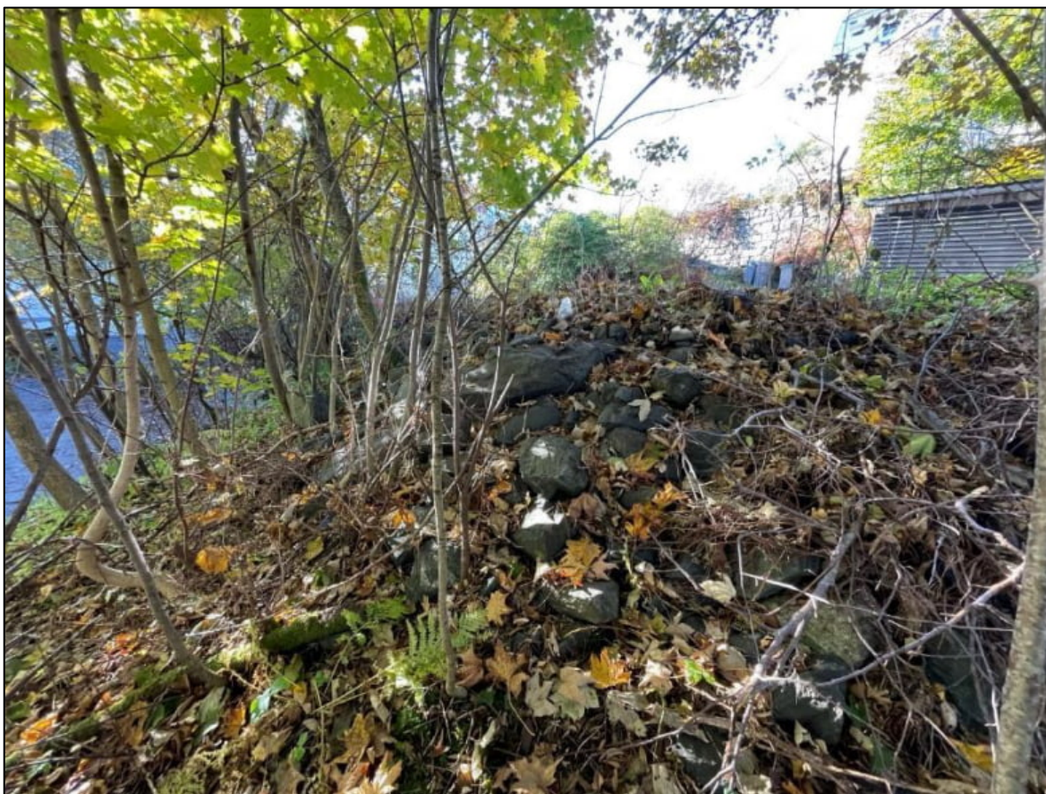
Figur 8. Fyllmasser i skråning hellende mot øst, like sør for Nesttunvegen 99.
