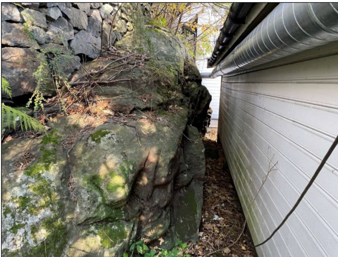
Figur 10. bergskrent med oversliggende natursteinsmur i bakkant av bygg ved Nesttunvegen 99. Bolig på same adresse synlig bakerst i bildet, som også er bygget tett på bergskrenten.
