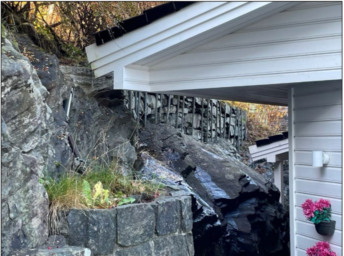
Figur 6. Natursteinsmur bak bolig på adresse Nesttunvegen 97 er sikret med svartstål.
