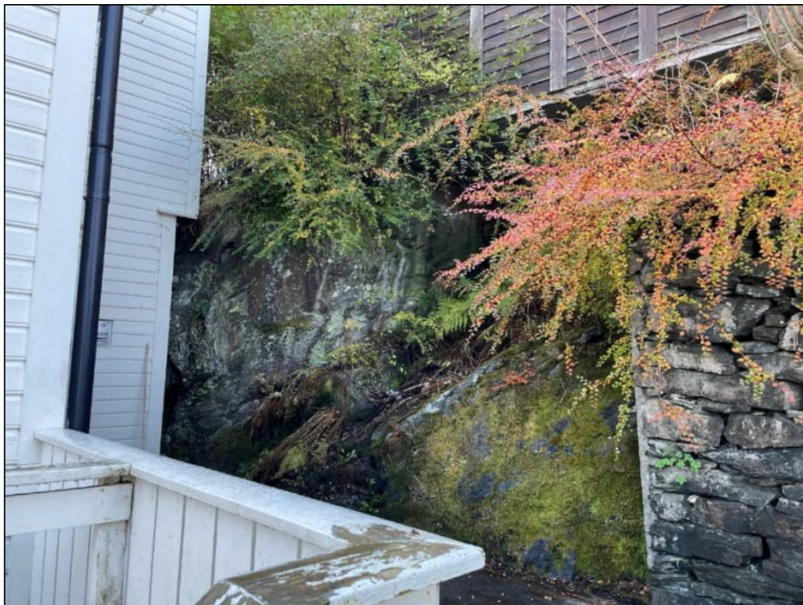
Figur 9. Bergskrent i bakkan tav Nesttunvegen 99 (merk at bilde er tatt på nivå med 2. etasje av bolig). Huset er bygget så tett på skrent at det ikke er tilgjengelig å observere berg i bakkant av bolighus.
