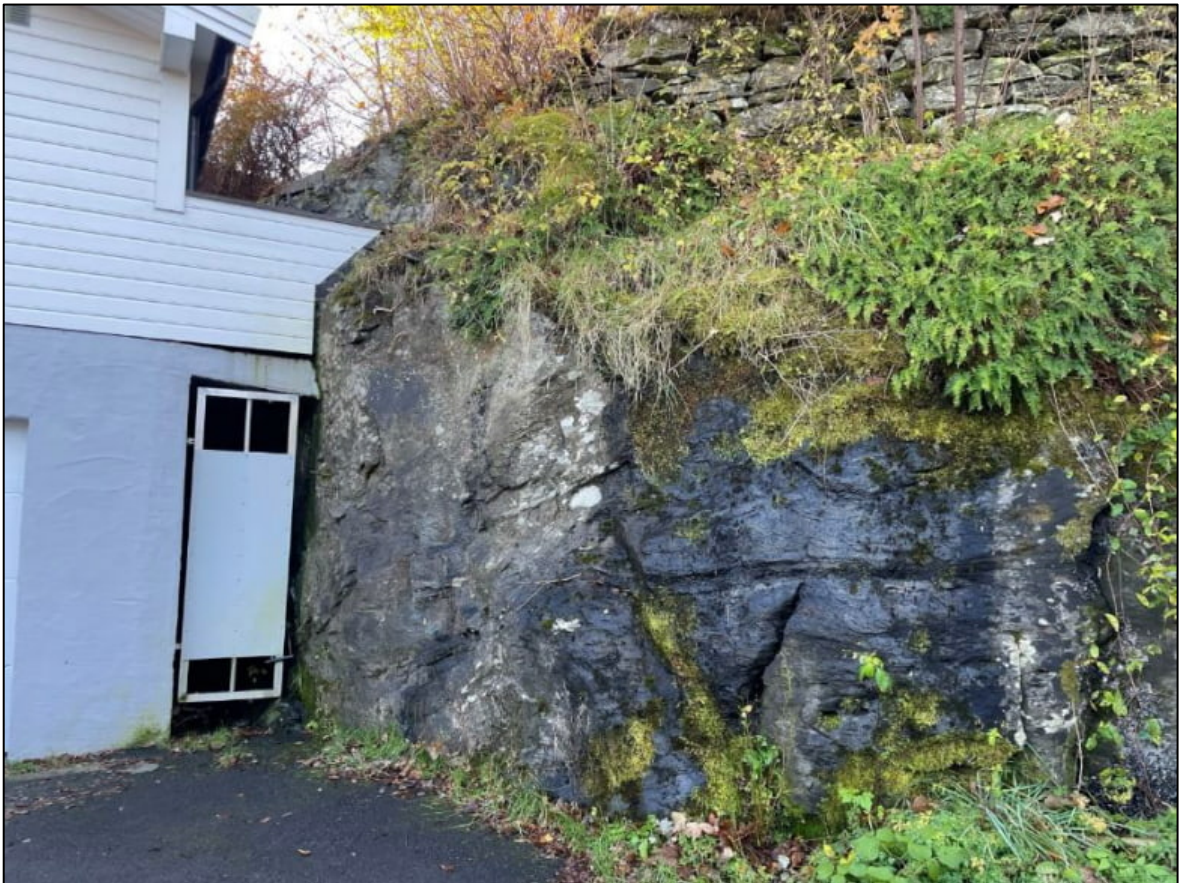
Figur 4. Natursteinsmur i underkant av Nesttunvegen 101B mot nordøst. Det er også natursteinsmur i bakkant av Nesttunvegen 97 støttet opp av svartstål fundamentert i berg. Se Figur 6 for bedre bilde.
