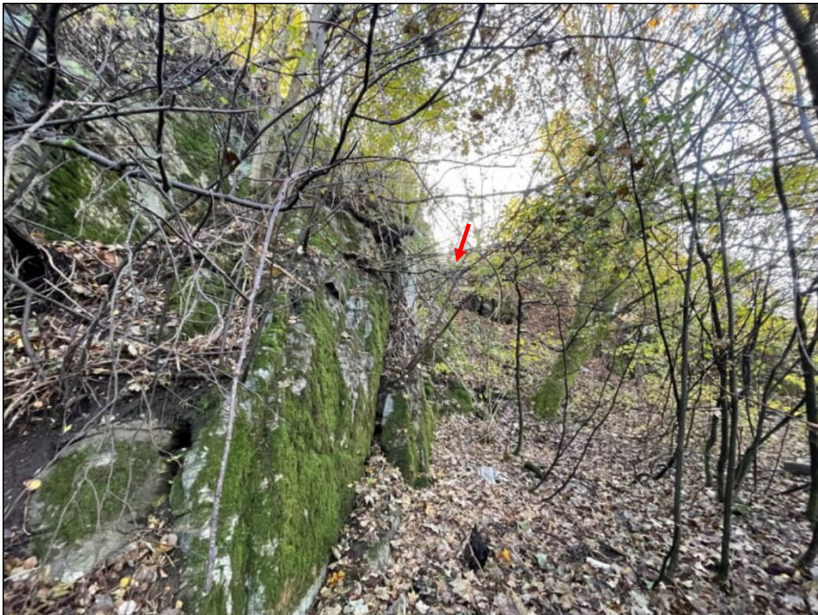
Figur 1. I vestlig del av området, ned mot Lille Nesttunvann, er det vegetasjon i form av løvskog tett mot bergskrent. Mur i underkant av Nesttunvegen 101A mot vest er lite synlig i toppen av bergskrent (rød pil).
