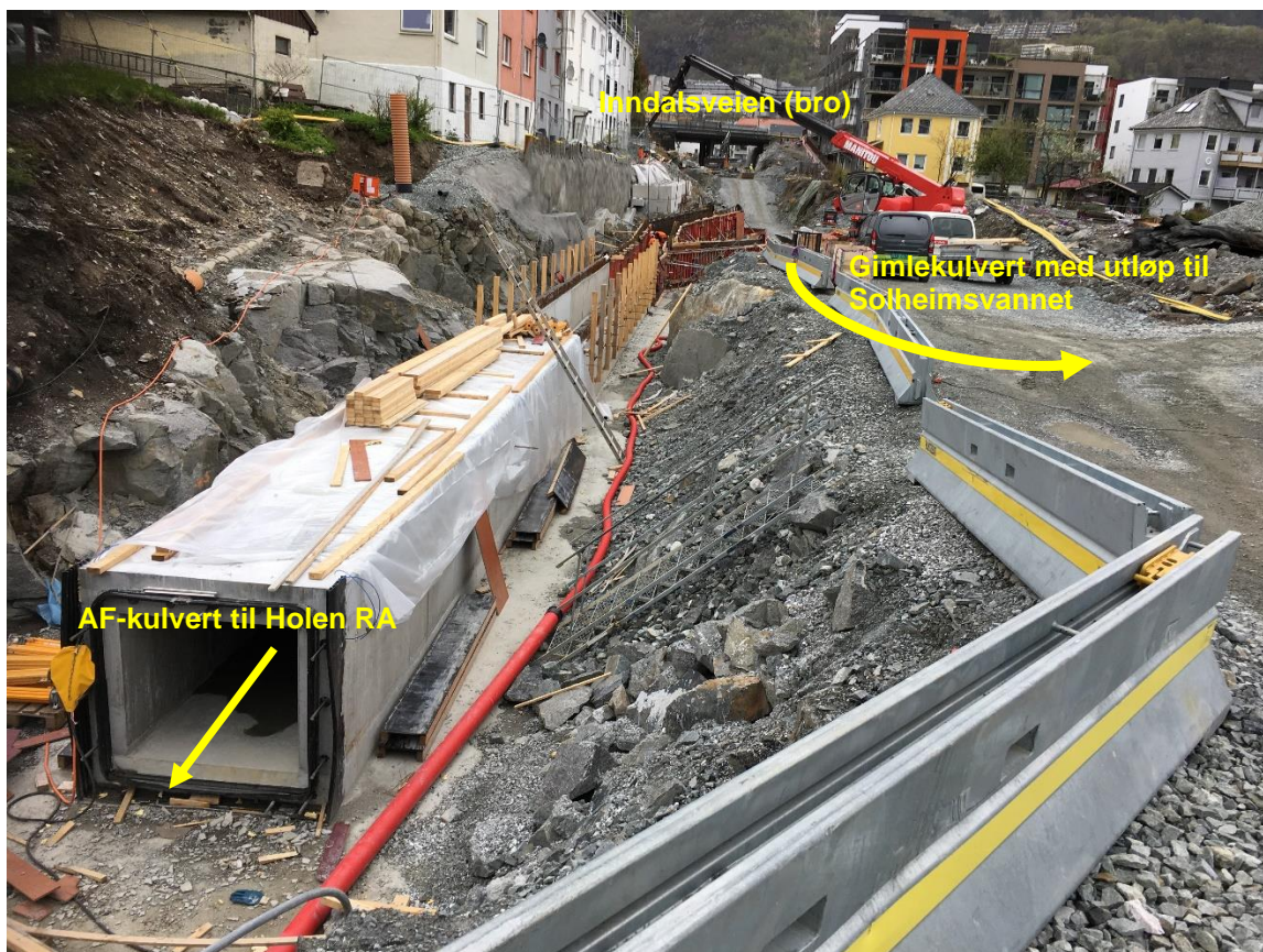
Figur 5 Avløpskulverten fra Gimle mot tunnelpåslaget til Hølen. I bakre del av bildet svinger overvannsdelen av kulverten inn mot Solheimsvannet til høyre utenfor bildet. Under bybanesporet fra Kronstad er avløps- og overvannskulverten støpt som en kulvert med skillevegg.
