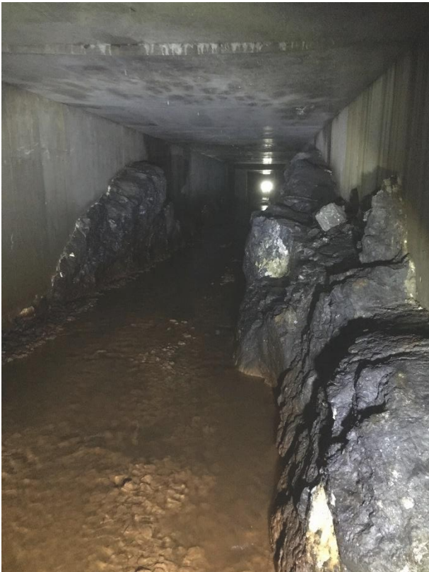
Figur 4 Kulverten under Høyskolen i Bergen.
