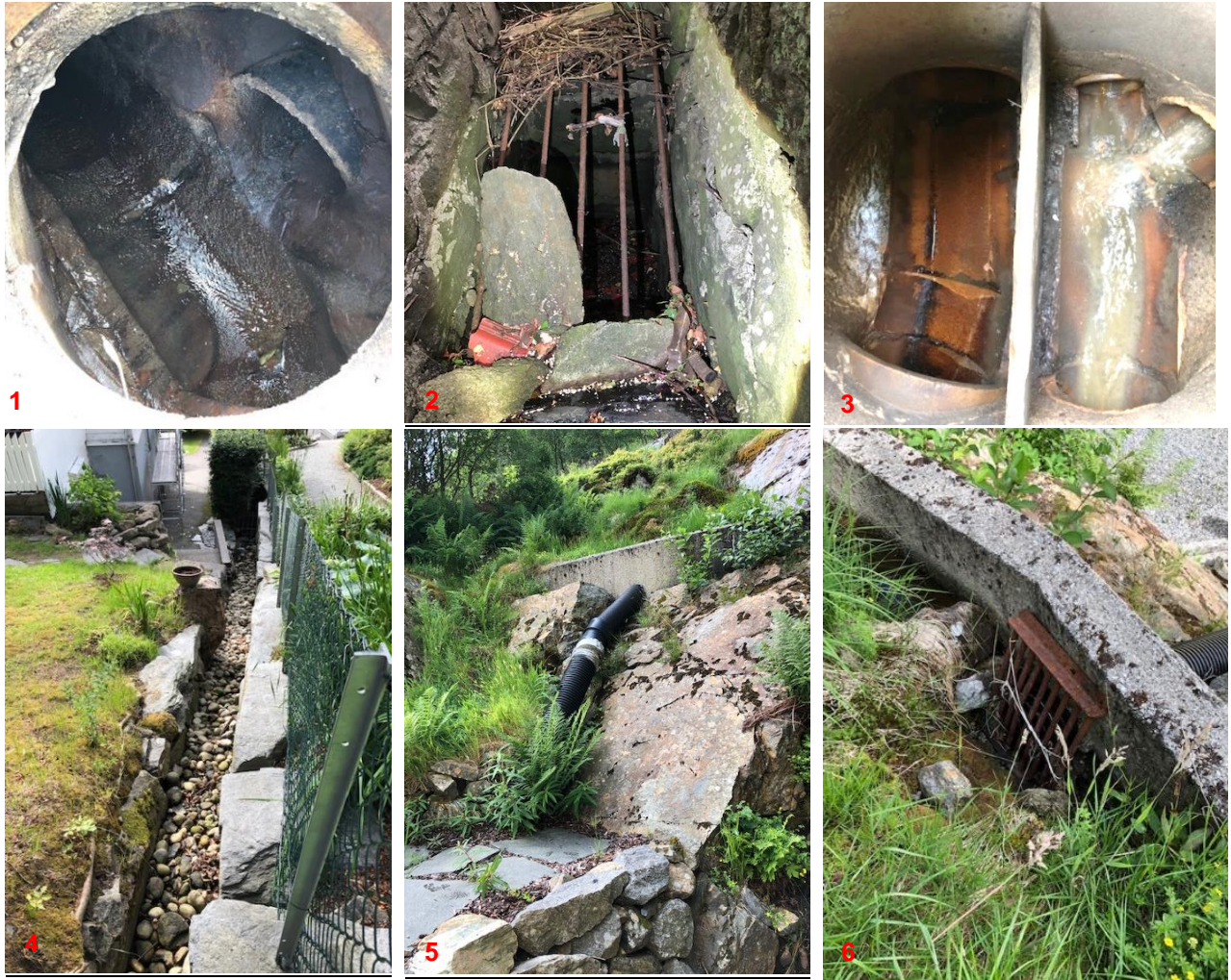
Figur 3 Bildene er fra Løvstakksiden oppstrøms Mindebyen. Overvannsystemet oppstrøms Mindebyen består av eldre overvannsløsninger. Det innebærer at hvor og hvor mye vann som når frem til Mindebyen avhenger av drift (rensk av bekkeinntak), kapasitet i oppstrøms system og fremtidige oppdimensjonerings og omlegginger for å møte klimaendringene. (1) Viser overvannskum med et innløp og to utløp. (2) Delvis tett bekkeinntak. (3) Overløp mellom avløp felles og overvanns-nettet. (4) Bekkeføring gjennom privat hage. (5) og (6) er innløpsbegrenset bekkeinntak ved privat tomt.
