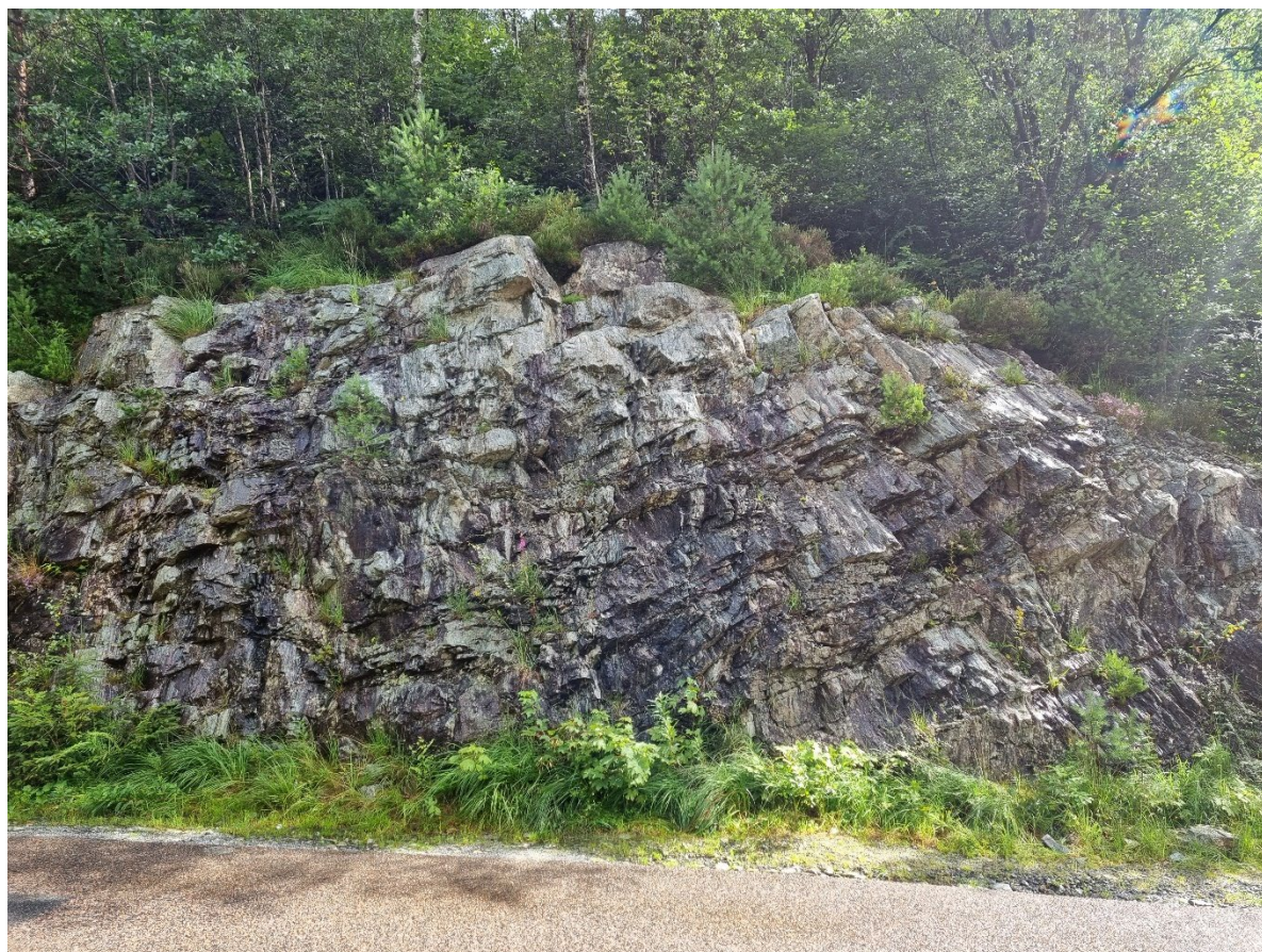
Figur 3. Eksisterende skjæring i vestre del av tiltaksområdet. Foten av skjæringen ligger på ca. 70 moh.
