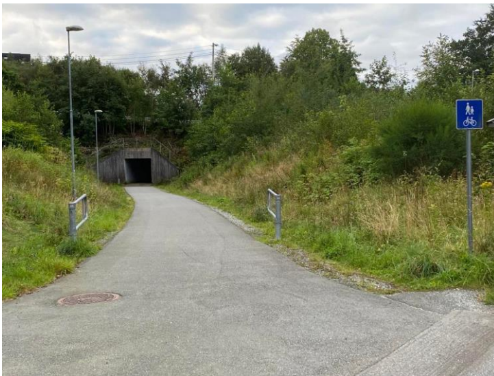
Figur 4. Undergang ved Folldalsheia.
