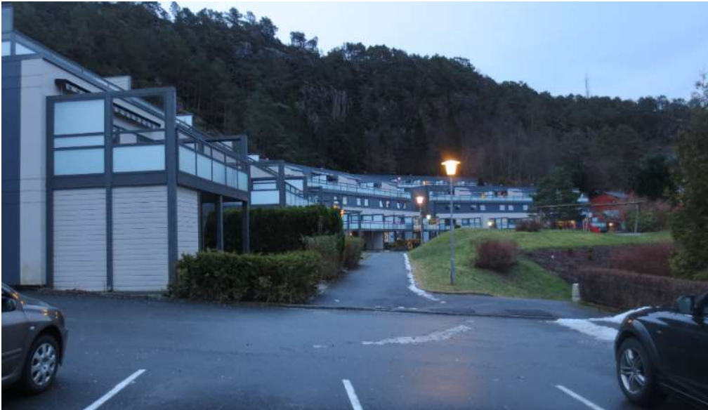
Figur 6-22 Nærmeste lekeplass ligger midt i Bjørndalsbrotet borettslag.
