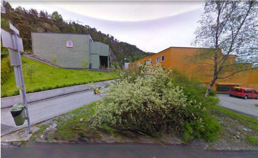
Figur 9-16 Bilde fra google maps som viser eksisterende bebyggelse i Bjørndalsbrotet 60 og 122 fasader ut mot veien.
