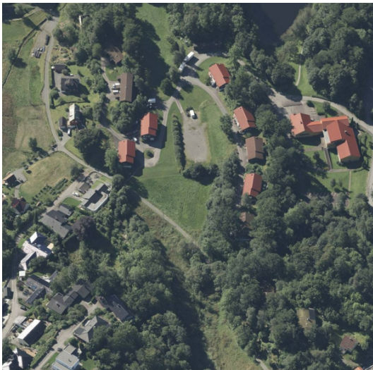
Figur 3: Flyfoto av planområdet og omkringliggende bebyggelse. Sett fra nord.
