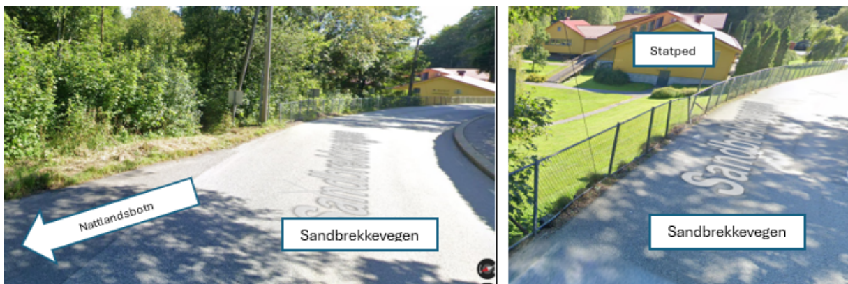
Figur 9: Viser dagens situasjon i Sandbrekkevegen. Langs vest hvor det er planlagt utvidelser med gang- og sykkelvei, går det i dag et gjerde.
