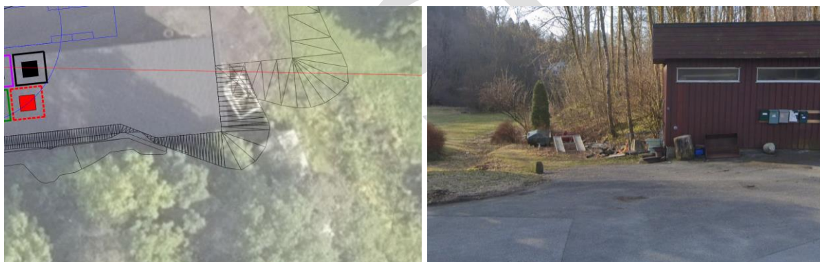
Figur 4-29 Til venstre: Planlagt fylling i bestemmelsesområde #4 vist over ortofoto av dagens situasjon. Multiconsult. Til høyre: Bilde av området øst og sør for dagens garasje, som benyttes til lagring av diverse utstyr. Google maps.
