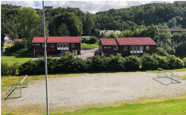
Figur 5-7 Sandbrekkevegen 32A og 32D.
