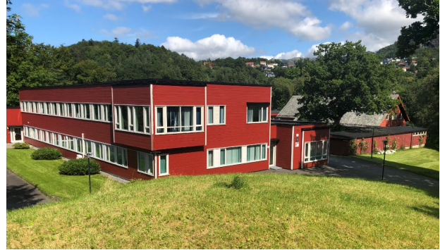
Figur 4-3 Statpeds hovedbygg, Sandbrekkevegen 27.
