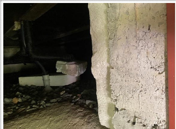
Bilde nr. 2.06 Porebetong på innsiden av ringmur. Bildet tatt på bygg 8.
