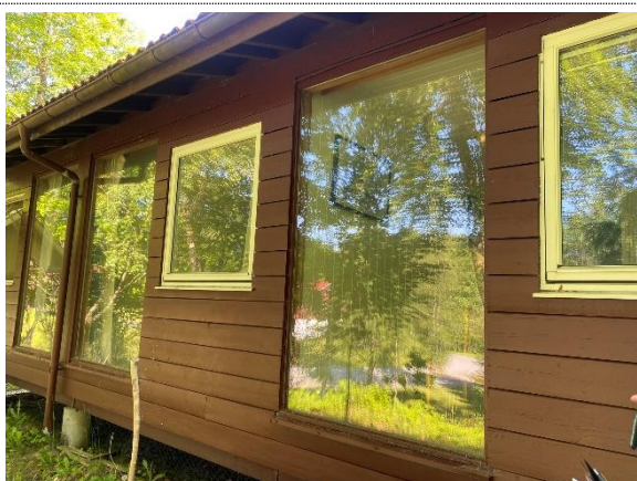
Bilde nr. 2.17 Store vinduer er fra byggeår.
