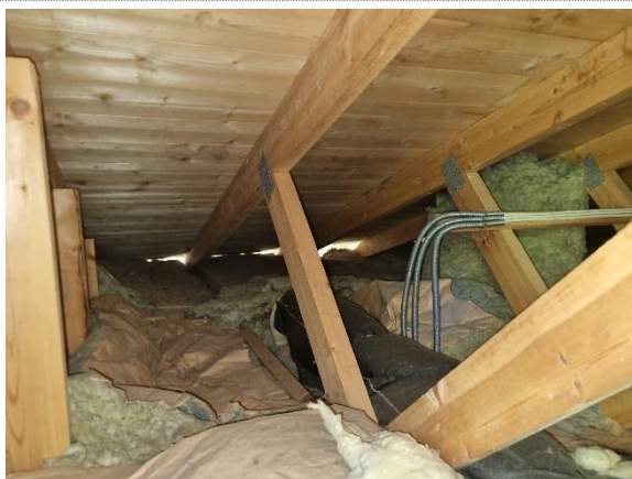
Bilde nr. 2.41 Innertak. Isolert etasjeskiller.
