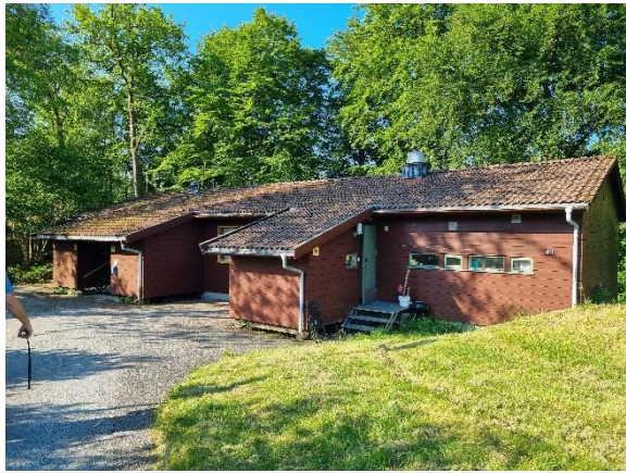
Bilde nr. 7.01 Bygg 9. Asfaltert tilkomst, gressplen og skog.
