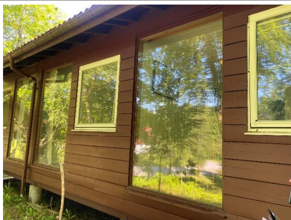
Bilde nr. 2.23 Vindu fra byggeår har vannbrettbeslag av metall i både under- og overkant av vindu.
