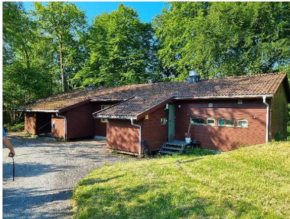
Bilde nr. 2.01 Oversiktsbilde over bygg 9 sett fra nordvest
