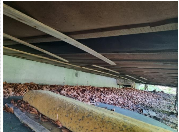
Bilde nr. 2.02 Ringmur til venstre i bildet.
