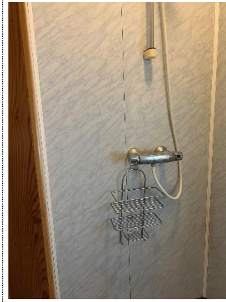
Bilde nr. 2.28 Baderomspanel som innervegger i våtsone på dusjrom.
