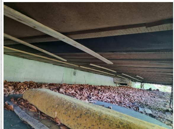
Bilde nr. 2.30 Underkant av bjelkelag. Trefiberplater, buler mellom leker.
