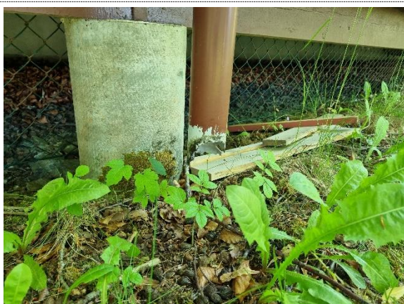
Bilde nr. 2.05 Nærbilde av søylefundament.
