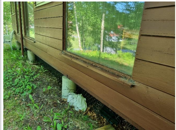
Bilde nr. 2.04 Sett fra sørvest. Søylefundamentering, søyler støpt i rør av eternitt.
