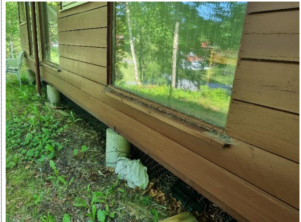
Bilde nr. 7.04 Fundamenter tilpasset terrenget ved bygg 9.
