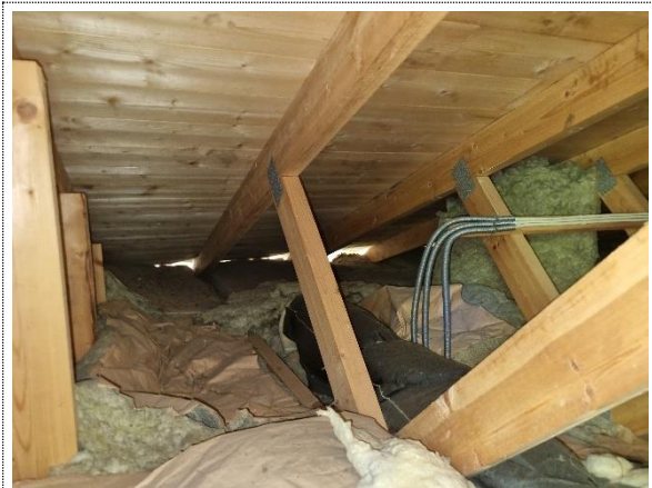
Bilde nr. 2.34 Etasjeskillet mot kaldloft er isolert med mineralull.
