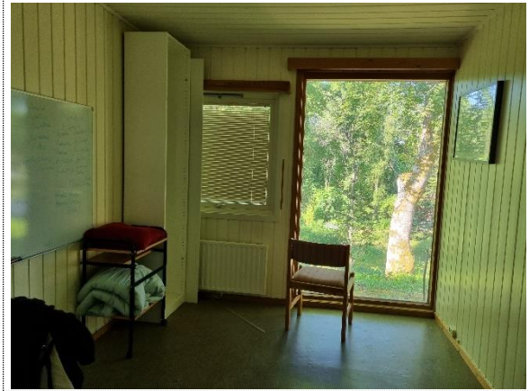
Bilde nr. 2.26 Innervegger av stående trepanel, malt overflate.
