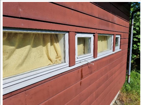
Bilde nr. 2.22 Vindu med vannbrettbeslag av metall i underkant av vindu.
