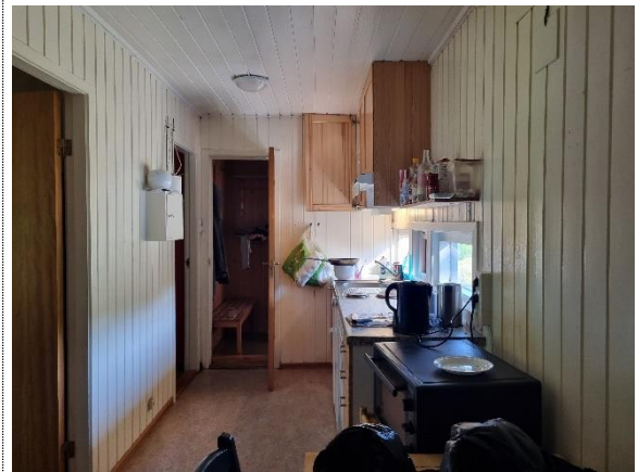
Bilde nr. 2.38 Himling av trepanel med malt overflate.
