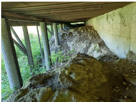
Bilde nr. 2.09 Bygg 8. Søylerekke som opptar høydeforskjeller fundamentert på fjell til venstre, ringmur til krypkjeller til høyret
