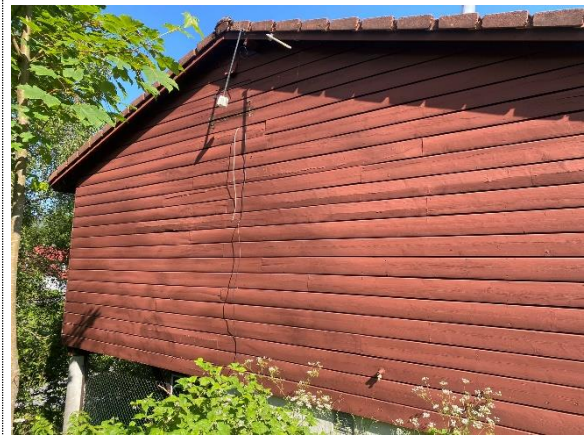
Bilde nr. 2.14 Kledning på vegg mot sør.
