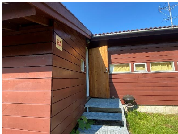
Bilde nr. 2.13 Yttervegger i bindingsverk med liggende kledning.
