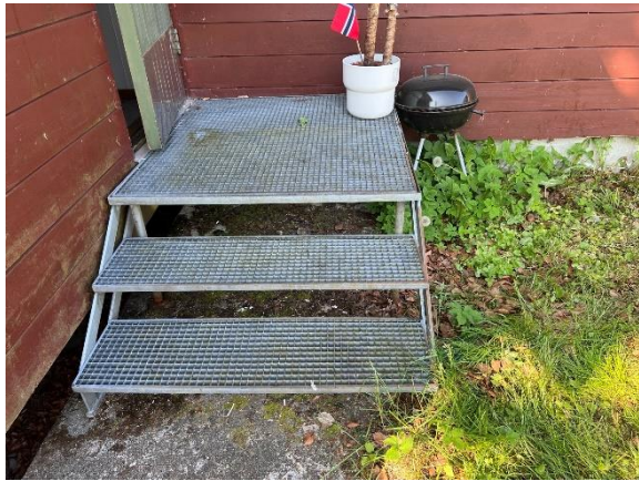
Bilde nr. 2.45 Ståltrapp ved inngangsparti.
