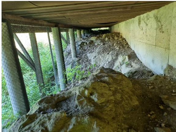
Bilde nr. 7.03 Fundamenter tilpasset terrenget ved bygg 8.
