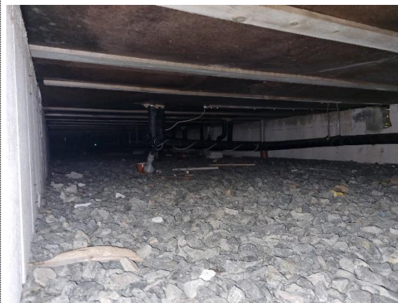
Bilde nr. 2.10 Bygg 8. Kryperom. Ventil i ringmuren til høyre i bildet.
