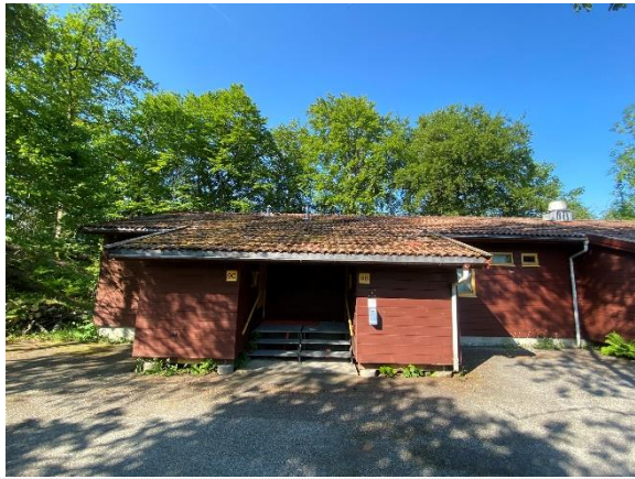
Bilde nr. 2.49 Takoverbygg over inngangsdører til to av leilighetene i bygg 9.
