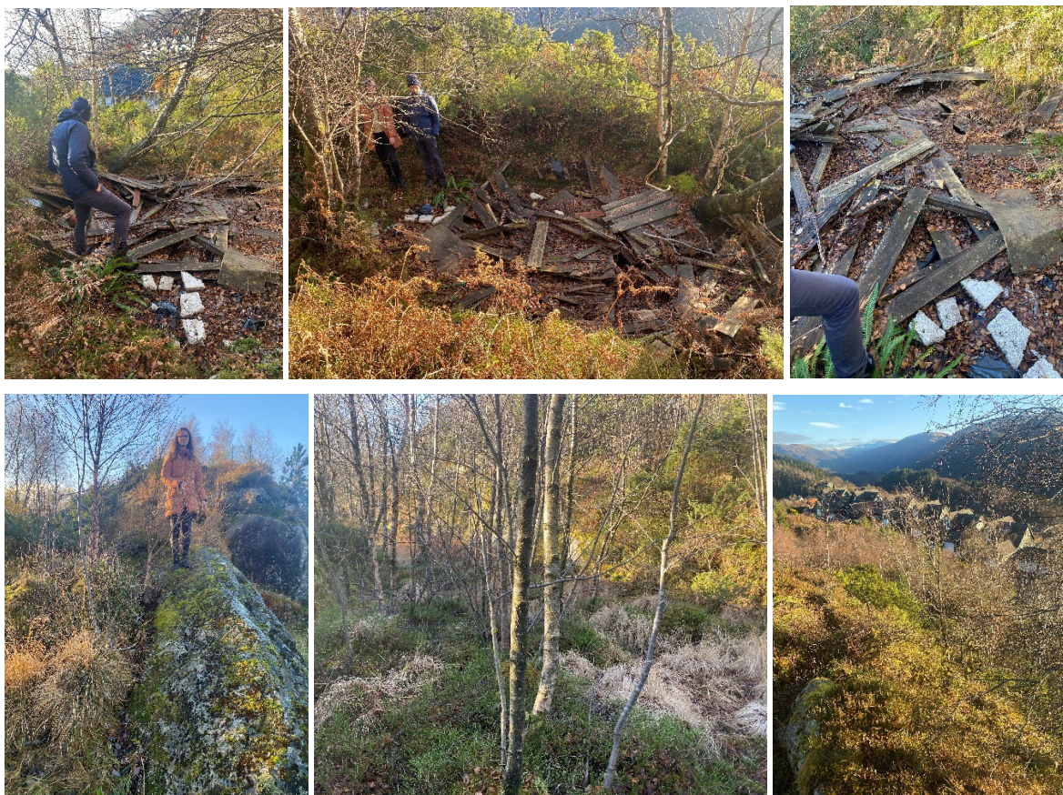
Figur 4-1: Øverste fotorekke: det sammenraste bygget. Nederste: Planområdet er skogkledd og med einer, gresstuer og lyng som markdekkende vegetasjon. Det er en del berg som vises i dagen. Området ligger høyt og fritt med god utsikt mot øst.
