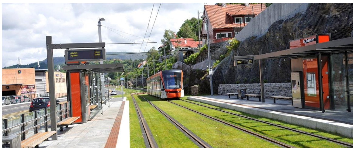
Figur 5: Bilde av Bybanen, foto: Jan Magne Sviland
